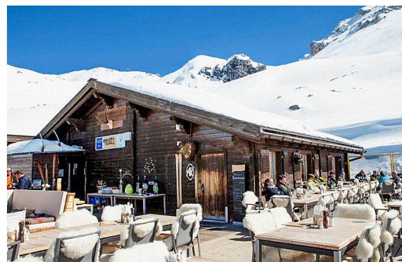
Gebäude vor dem Umbau Bâtiment avant transformation (Pressebild | Photo de presse)
