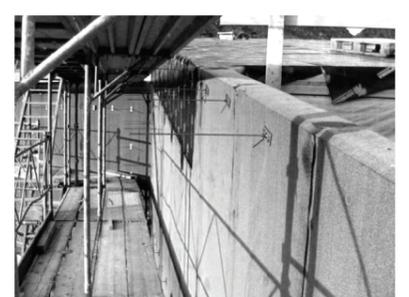
3. Dampfsperre wie auch der Ankerstab und der Abstandhalter für die spätere Schalung werden vom Zimmermann angebracht.
