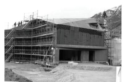
4. Zimmermann montiert die äussere Wärmedämmung auf die Dampfsperre. Für den nächsten Schritt, das Anbringen der Schalung und das Betonieren der äusseren Hülle ist kein Zimmermann mehr nötig.
