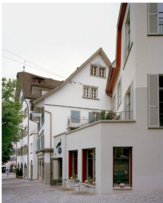
ROCKSPRUNG ZU GÜNSTEN EINER TERRASSE UND DES NACHBARN.
