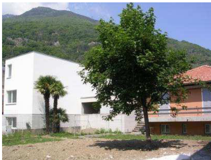
Vista dal giardino verso nord (garage oggetto della demolizione)
