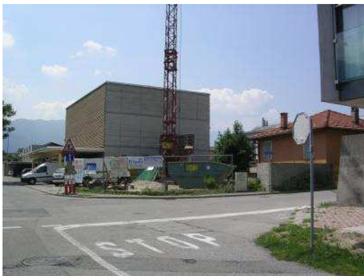
Vista provenendo da est
