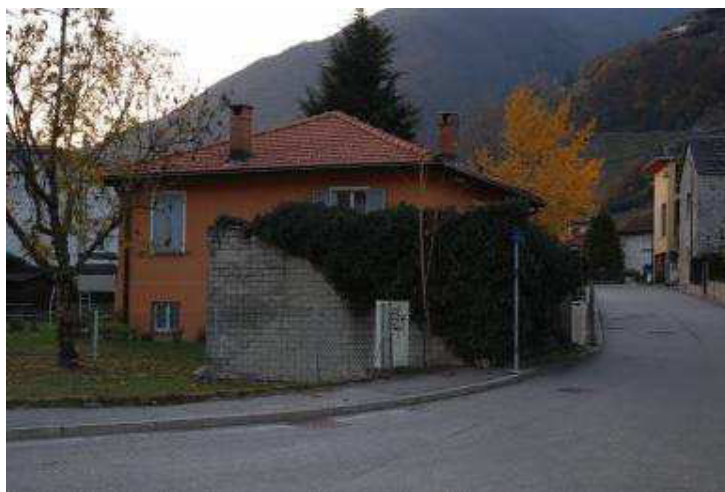
Vista andando verso nord (abitazione oggetto della demolizione)
