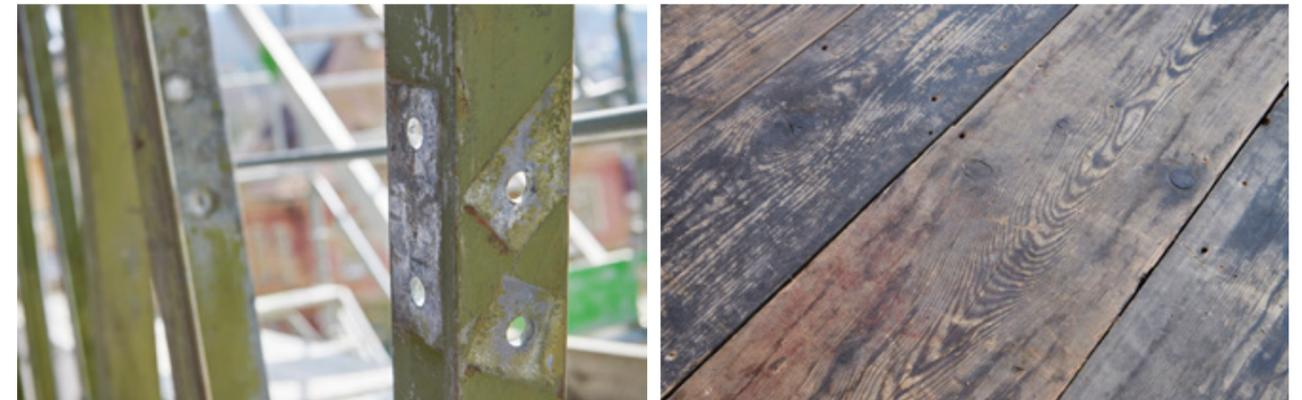
Detail der Außenfassade aus alten Profilen von Strommasten.
