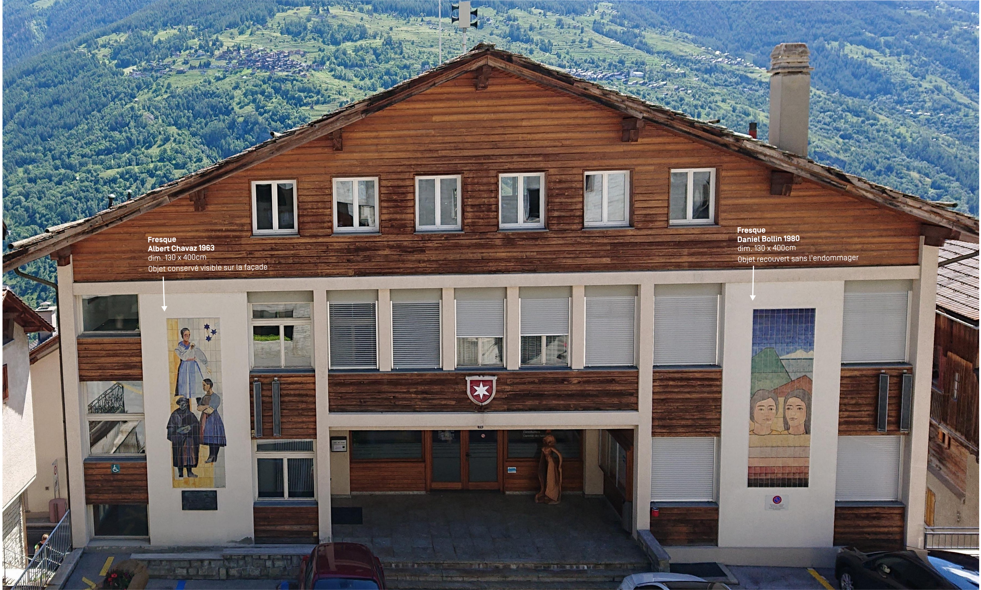
Façade Ouest, photographie, avant travaux
