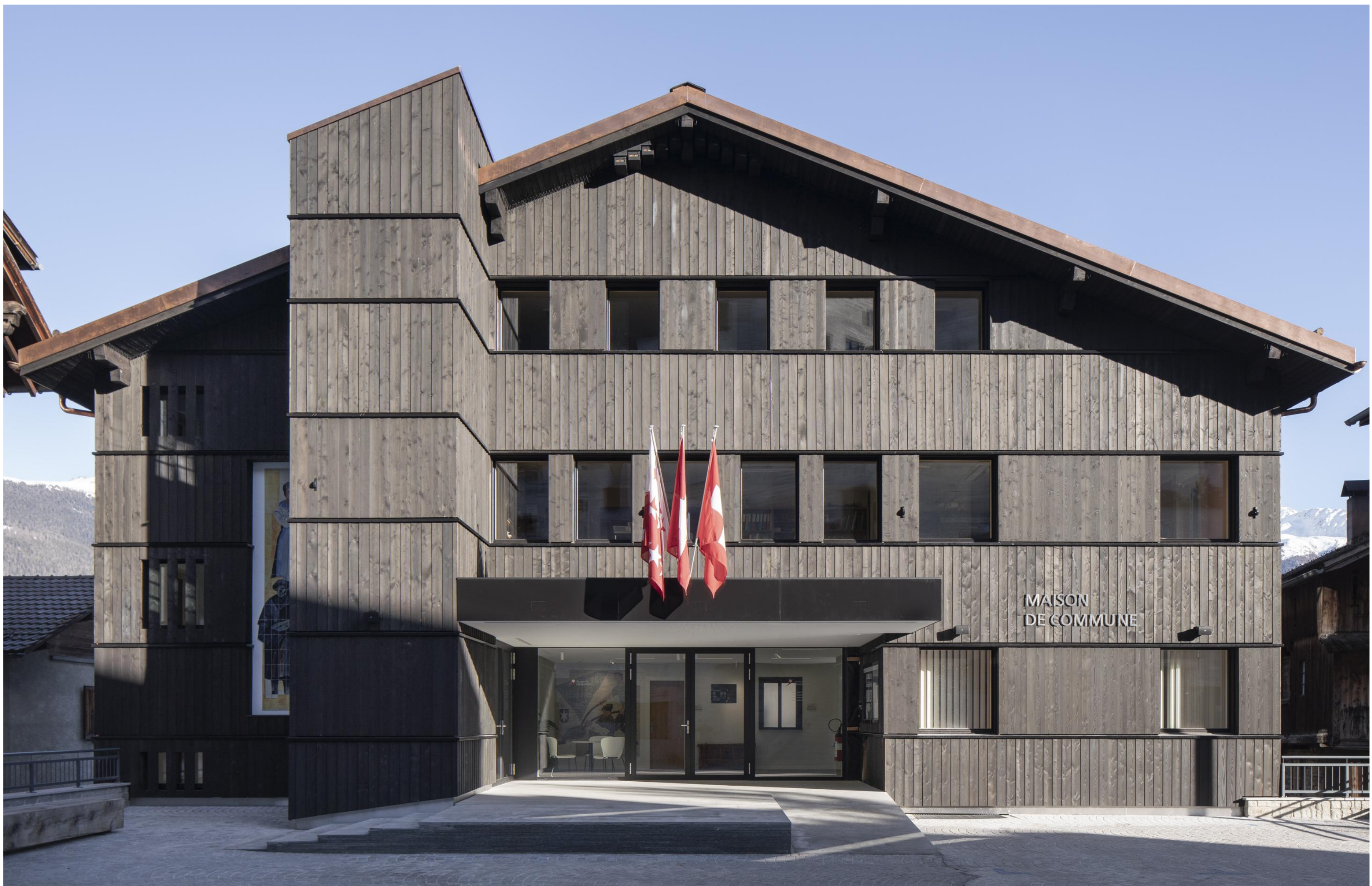
Façade Ouest, photographie, après travaux
