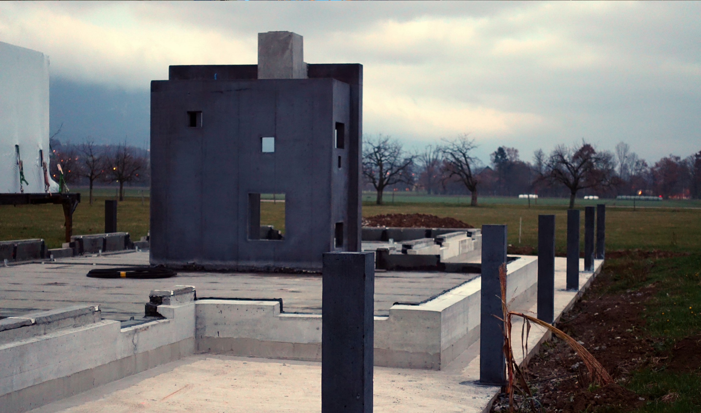
Fundament und Kamin mit Dusche
