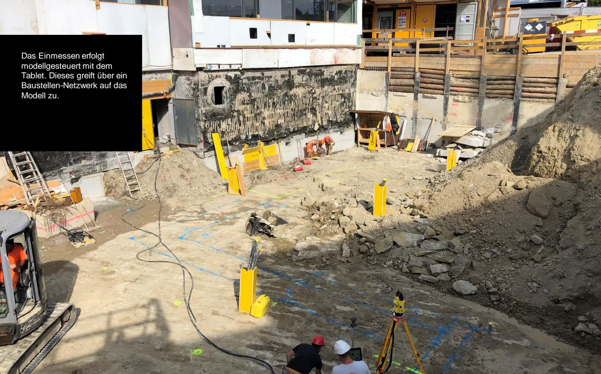
Am Tablet können nun die Punkte auf dem Modell ausgewählt werden, der Tachymeter steuert dann diesen Punkt an. Dieses Vorgehen wurde auf der Baustelle sehr gut aufgenommen.
