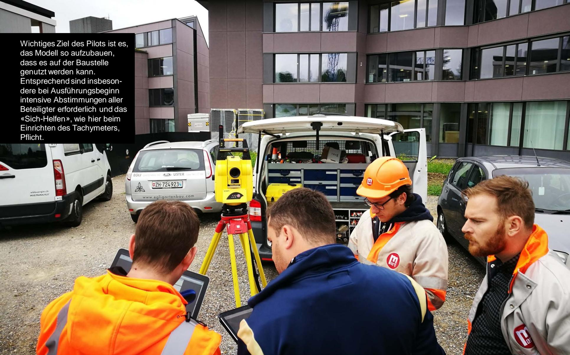
Das Einmessen erfolgt modellgesteuert mit dem Tablet. Dieses greift über ein Baustellen-Netzwerk auf das Modell zu.
