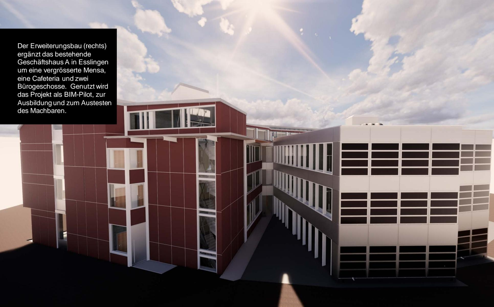
In Anlehnung an BIM-Maturity Level 3 gemäss englischem Stufenplan werden alle Elemente des Bestands wie auch des Neubaus in einem zentralen Modell abgebildet. Das heisst Architektur, Tragwerk, Grundbau und auch Haustechnik arbeiten synchron in einer Datenbank.
