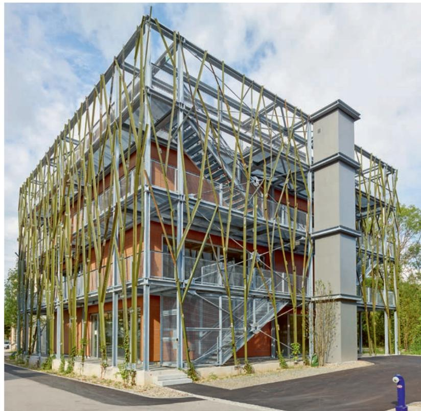
Die Metallstruktur der Aussenhaut dient als Rankhilfe für Kletterpflanzen. Der eigentliche Baukörper ist aus Holz.
