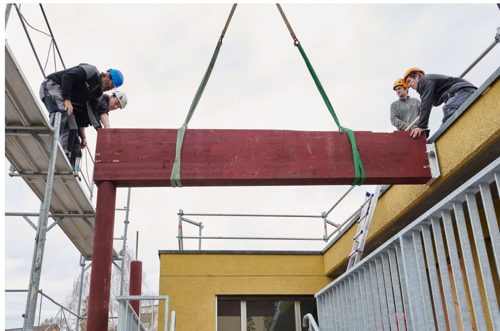
Einbau eines gebrauchten Holzträgers auf der Baustelle
