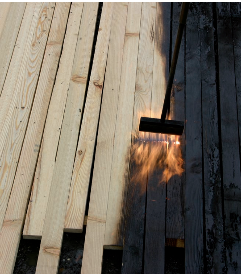
BRENNEN DER FASSADENLATTEN
