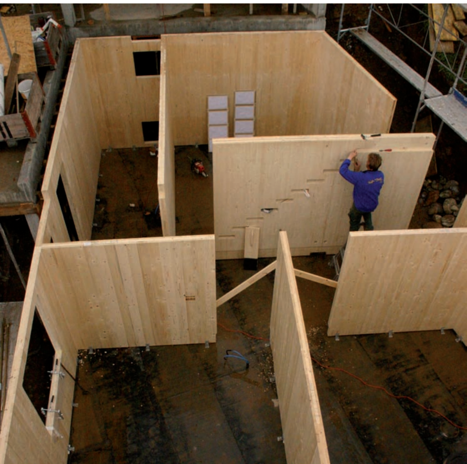
MONTAGE WÄNDE SCHLAFGESCHOSS
