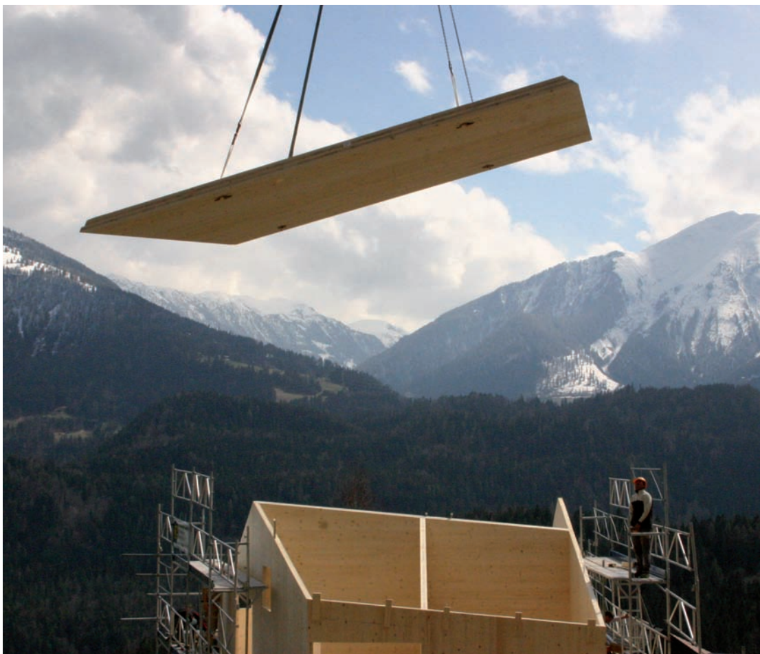
MONTAGE DACHPLATTE
