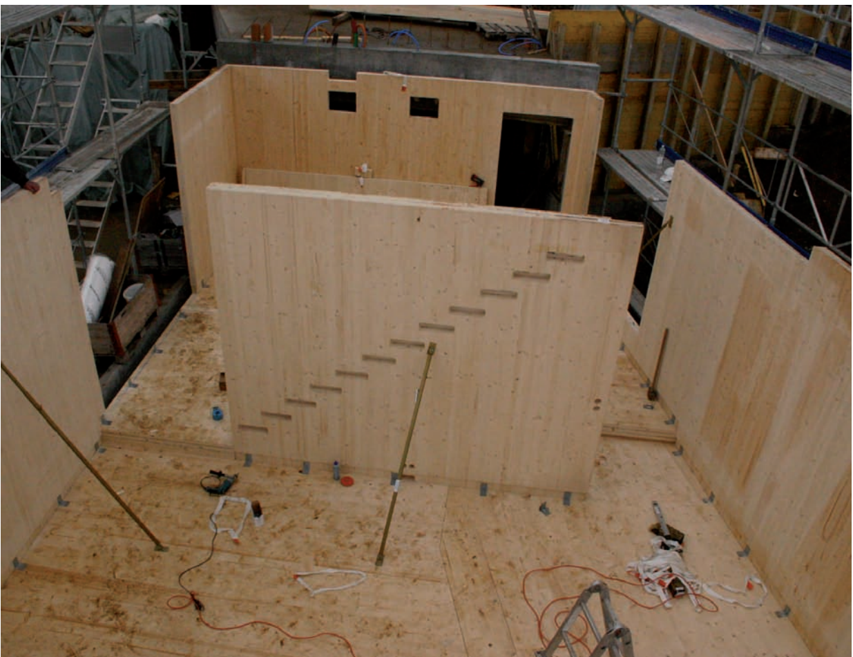
MONTAGE WÄNDE WOHNGESCHOSS
