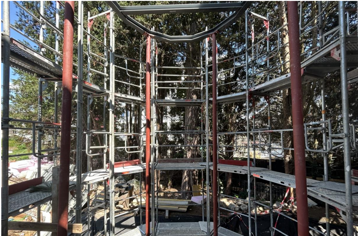
Strahlbau des Anbaus zur Villa Lindeneck mit Bettenaufzug
