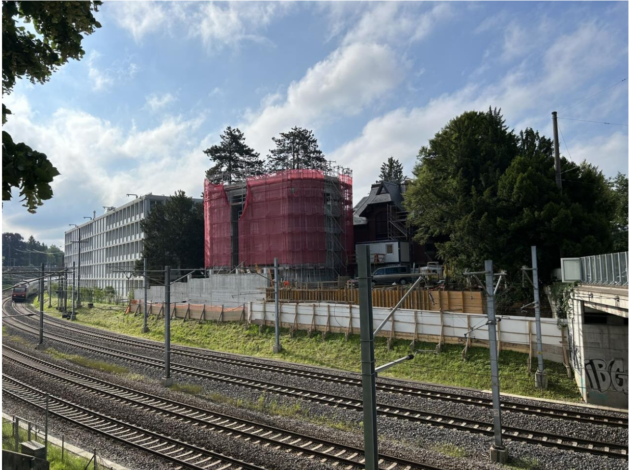
Baustelle im Juni 2024
