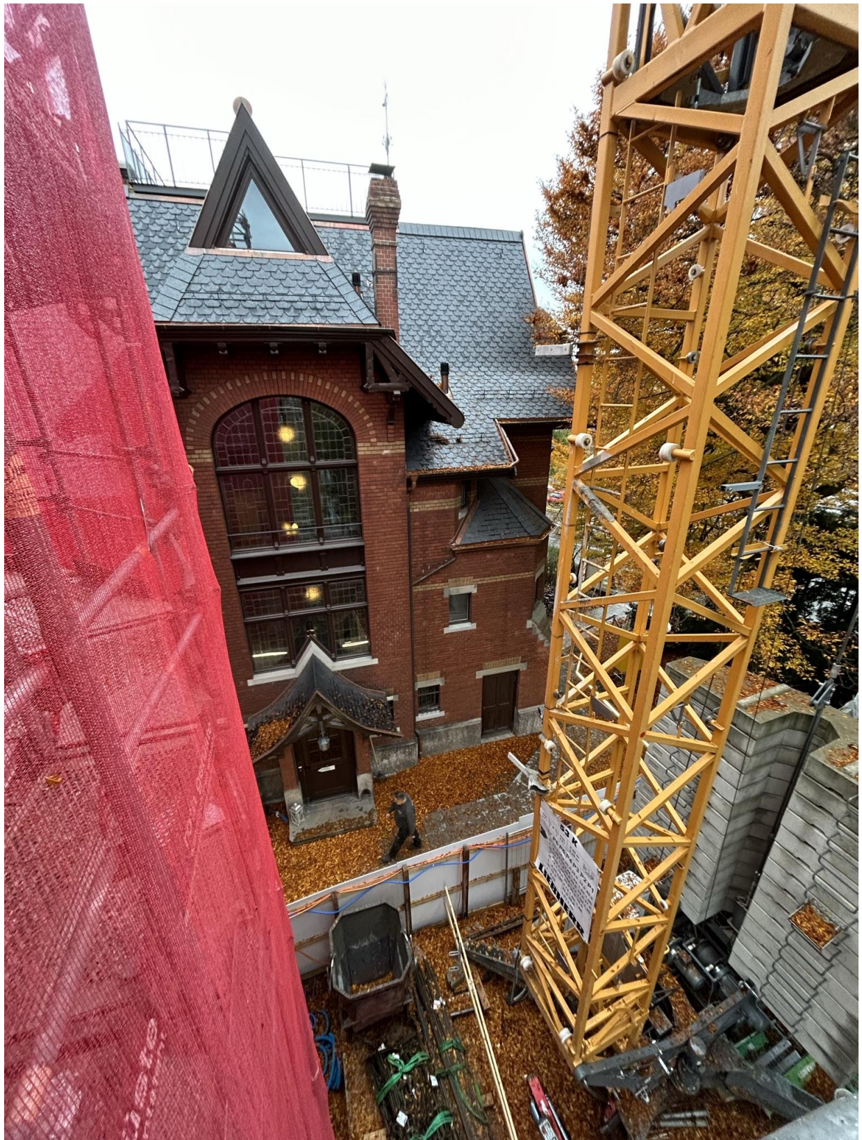
Baustellen-Installationsplatz auf minimaler Fläche mit Baumschutz im November 2023 Parallel zur Baustelle des Neubaus war das Geburtshaus schon mit separatem Zugang in Betrieb.
