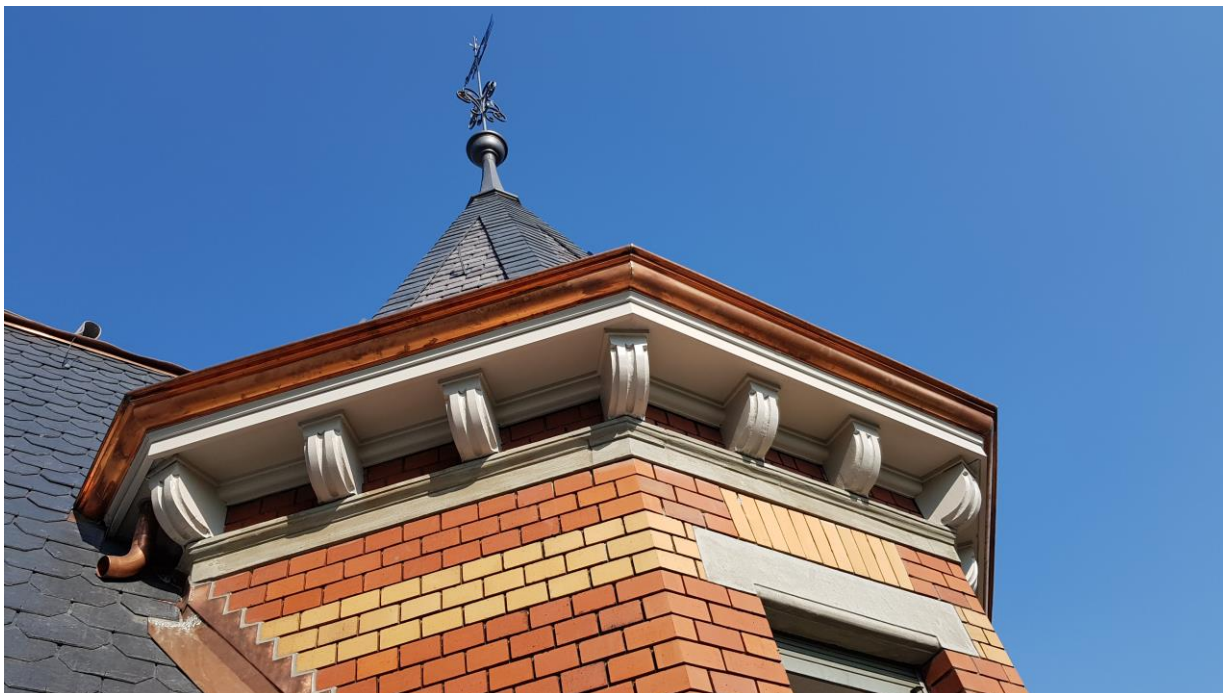
Dach ist neu gedeckt im Juni 23
