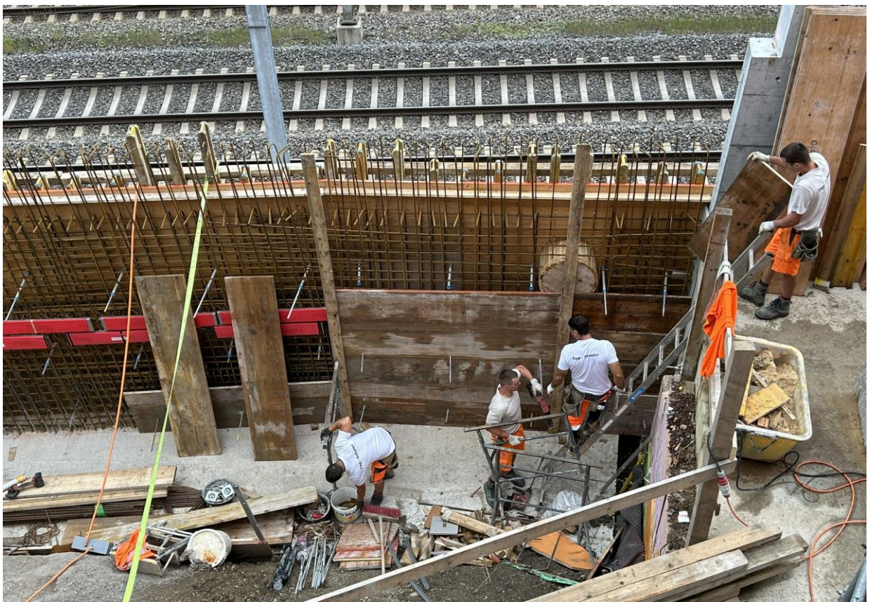
Arbeiten an der Schallschutzmauer
