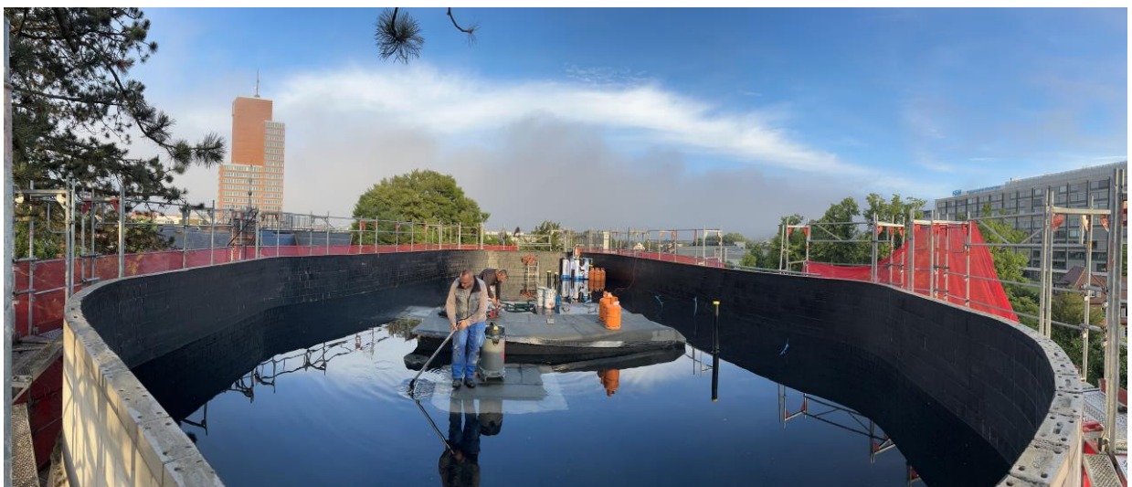
Dachgarten im Mai 2024
