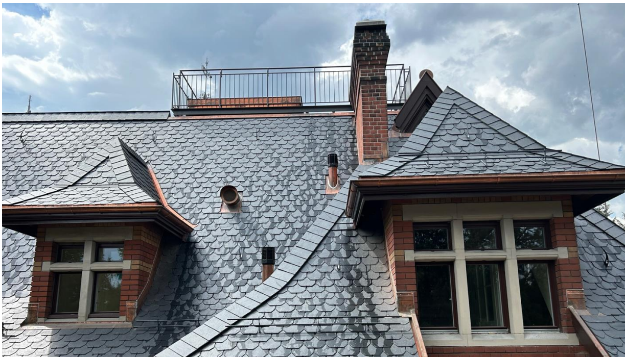
Villa Lindeneck nach der Renovation im November 2023
