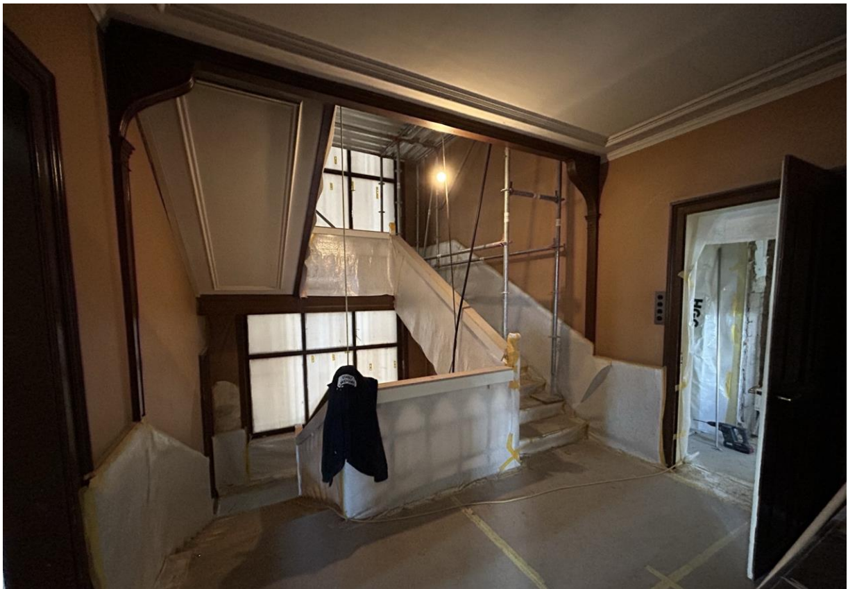
Innenausbau Küche Villa Lindeneck, März 2023
