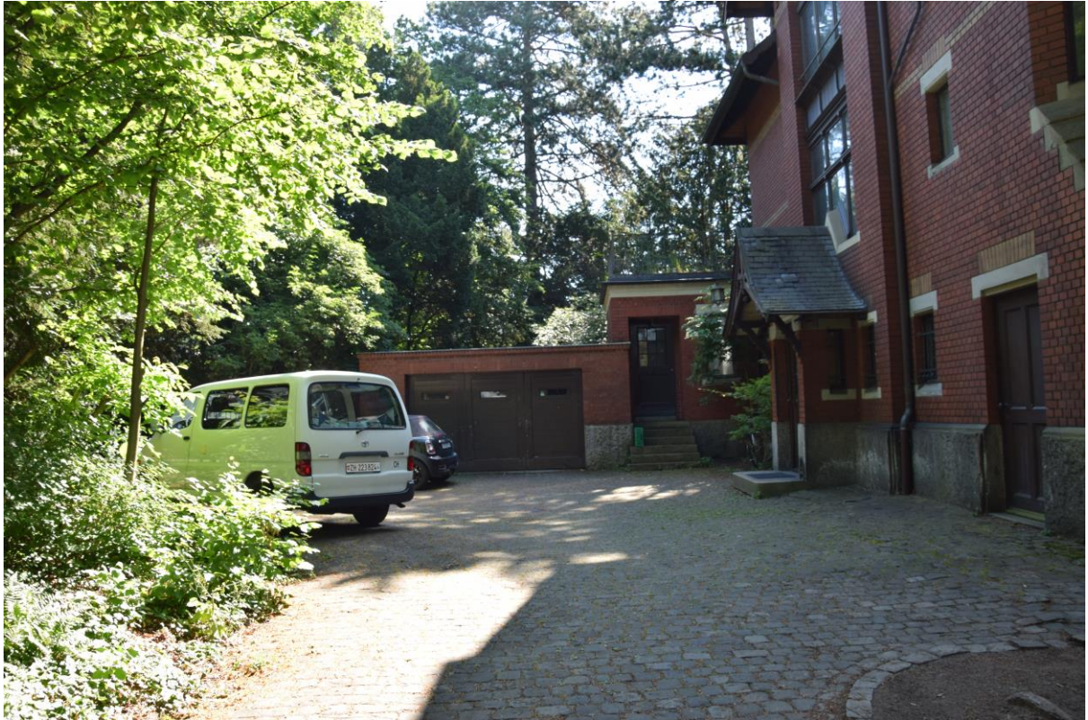
Villa Lindeneck vor der Renovation mit den Anbauten Garage und Frühstückszimmer
