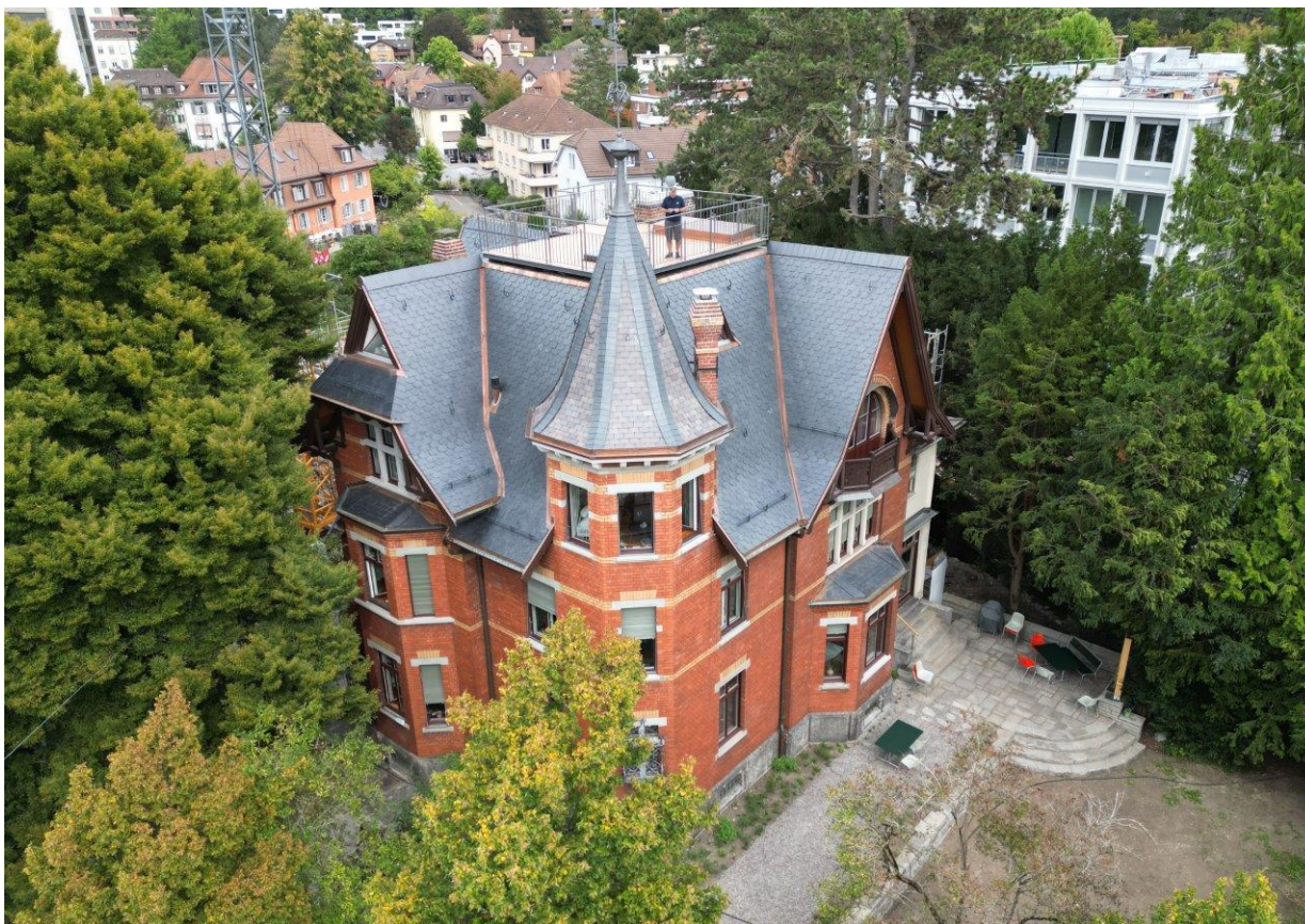
Villa Lindeneck nach der Renovation im November 2023
