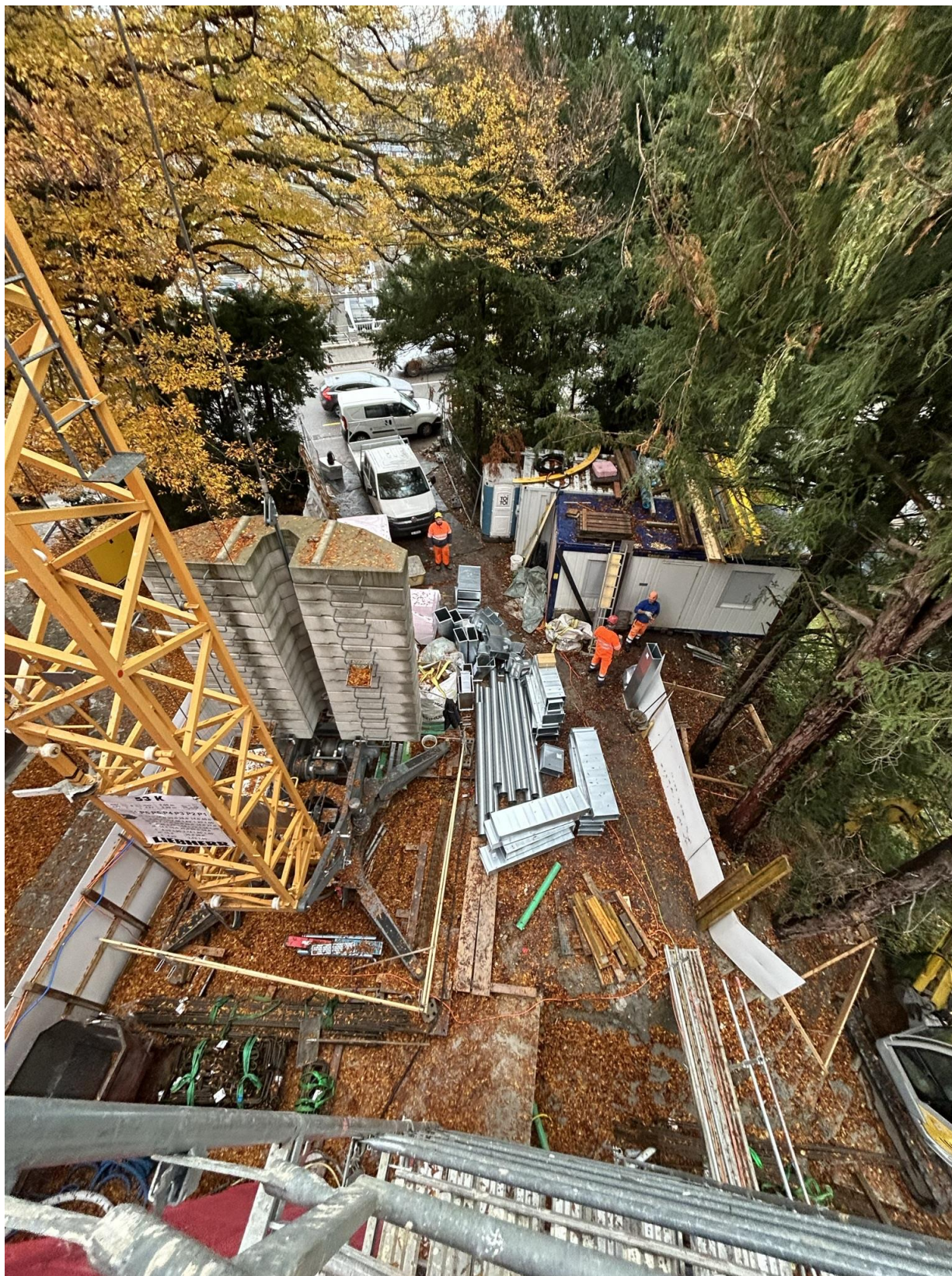
Baustellen-Installationsplatz auf minimaler Fläche mit Baumschutz im November 2023
