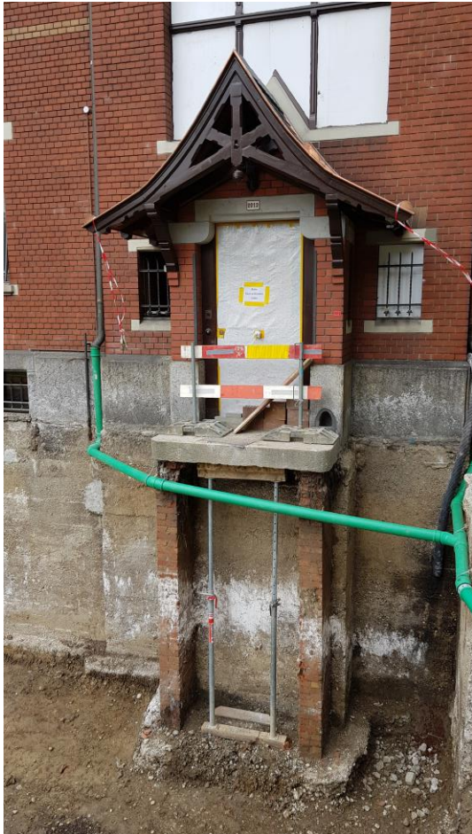
Baustelle Villa Lindeneck im März 2023
