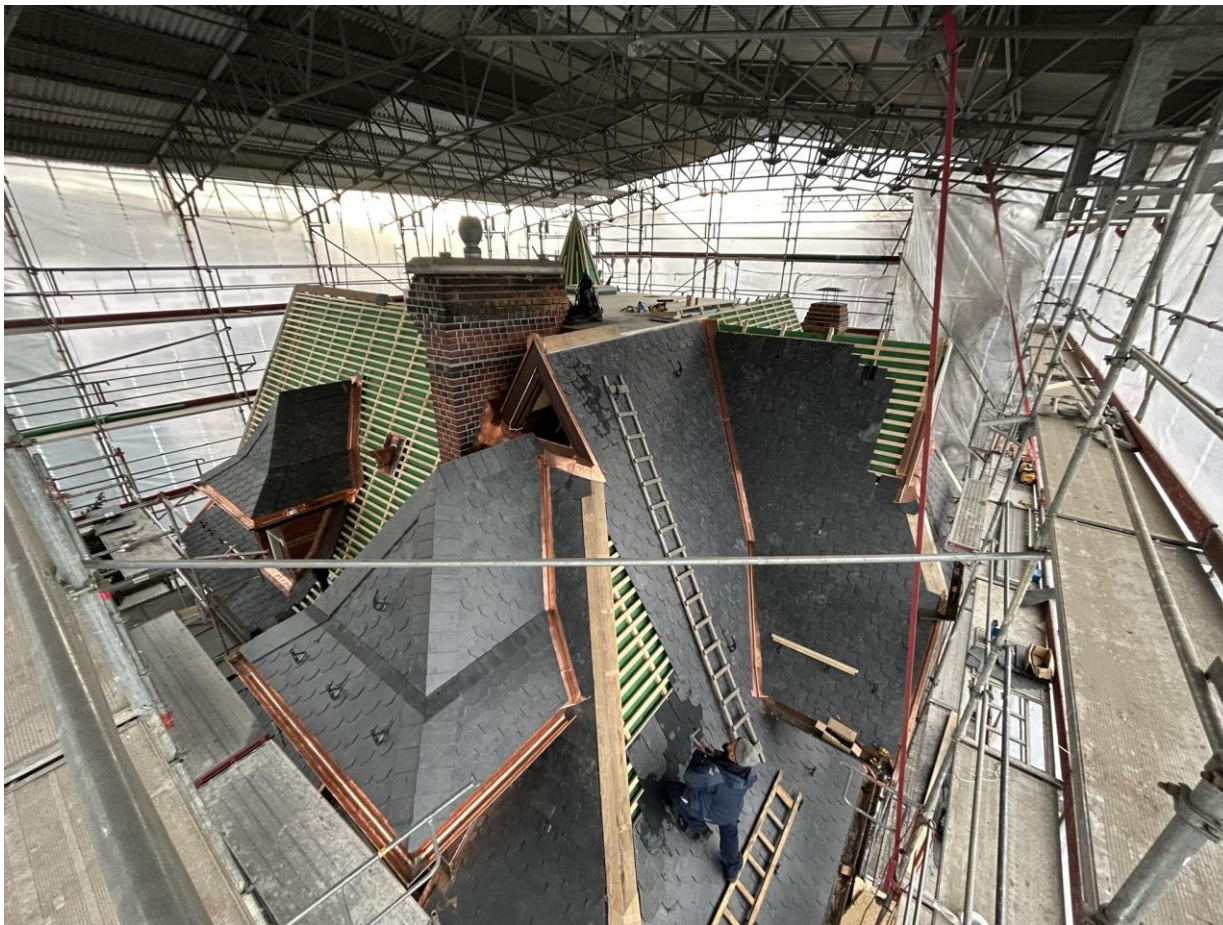
Totalsanierung Dach Villa Lindeneck im Mai 23
