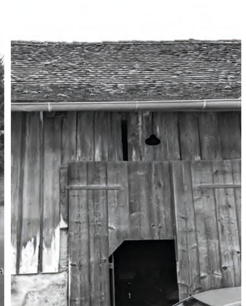
Die Südfassade zeigt den geziegelten und verputzten Schweinestall, dessen Putz teilweise abgefallen ist. Der Heustock ist ebenfalls mit Fichtenbrettern verkleidet, und im Westen grenzt ein offener Schopf an. Das Dach des gesamten Gebäudekomplexes, gedeckt mit Biberschwanz-Ziegeln, weist aufgrund von Bewegungen des Gebäudes Kurven und Wellen auf. Dieser physische Zustand des Gebäudes spiegelt seine historische Entwicklung und die Anpassungen an die sich ändernden Bedürfnisse und Funktionen wider.
