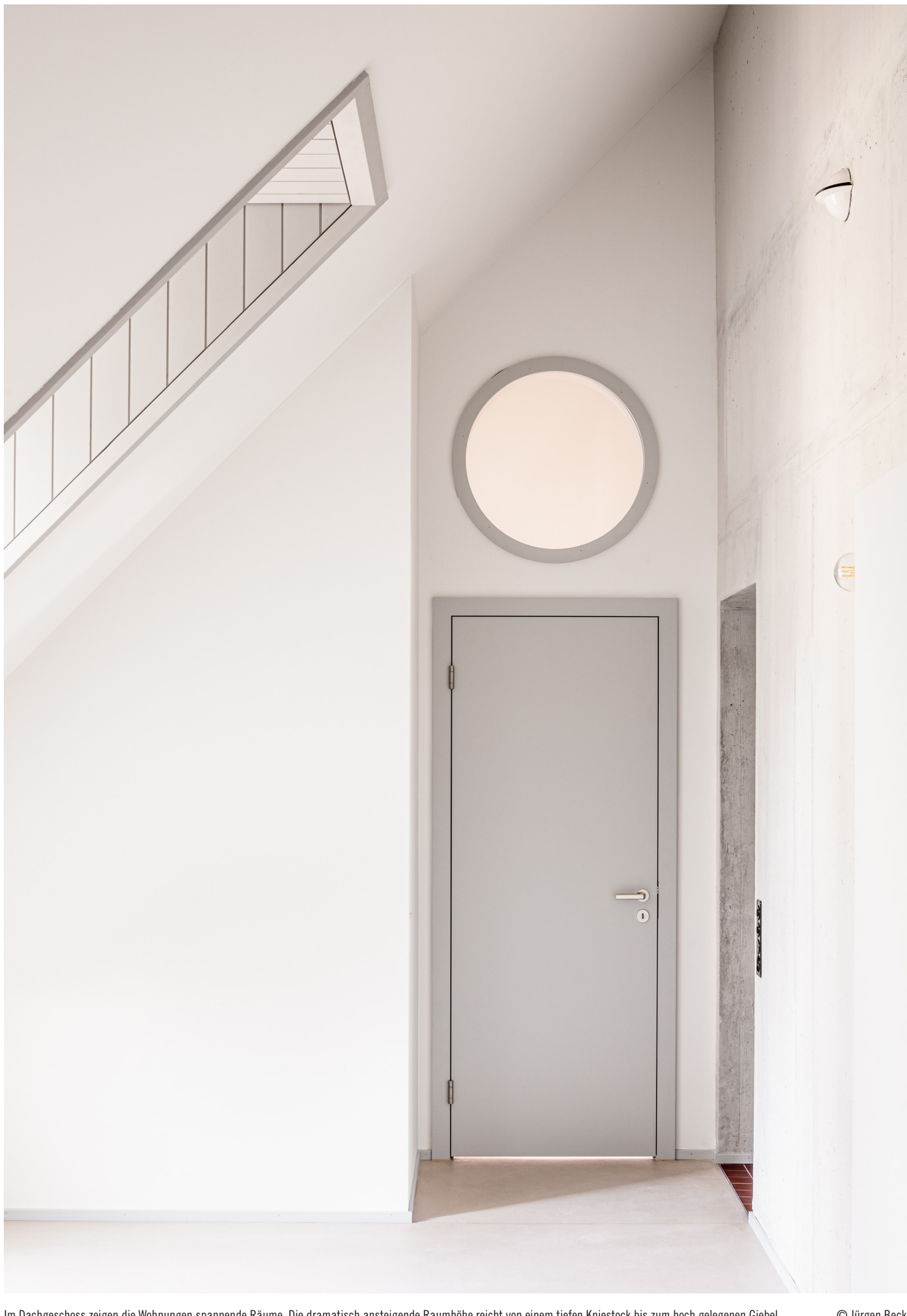
In Dachgeschoss zeigen die Wohnungen spannende Räume. Die dramatisch ansteigende Raumhöhe reicht von einem tiefen Kniestock bis zum hoch gelegenen Giebel. © Jürges Beck
