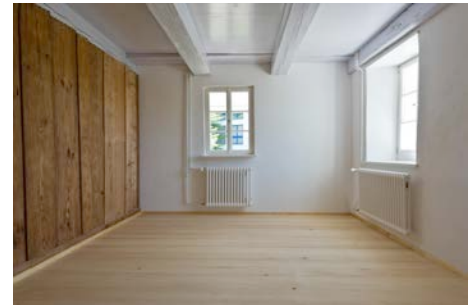
vorgefundene Holzwand im Obergeschoss
