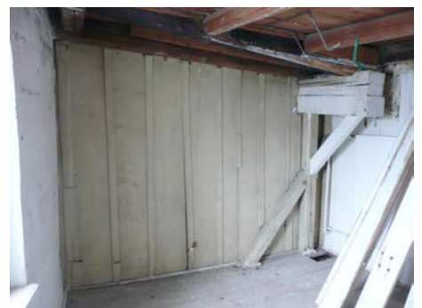
vorgefundenes Auflager der Firststütze
