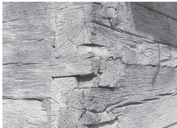
Referenz Eckverkämmung Blockbau
