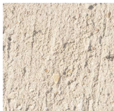
kalkputz gekratzt ( rotanteil )
