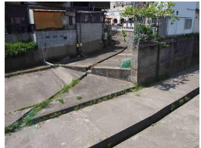
Abb. 17. Kurz vor der Kläranlage weitet sich der Kanal und nimmt weitere Zuflüsse auf. Die Wassermenge ist ein Grossteil des Jahres zu gering, um auch nur aus der mittleren Rinne zu treten.
