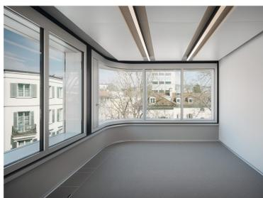
Eckbüro mit Fenstern als „Closed Cavity“ und Lüftungsfügel
