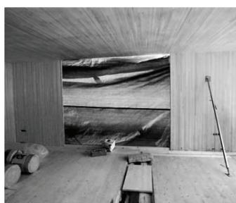
Holzbau muss vor dem betonieren des Aussenhülle gespriest werden (Betondruck)
