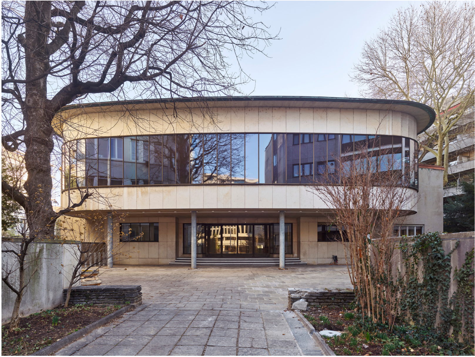
Aussenansicht Hauptzugang mit sanierter Fensterfront
