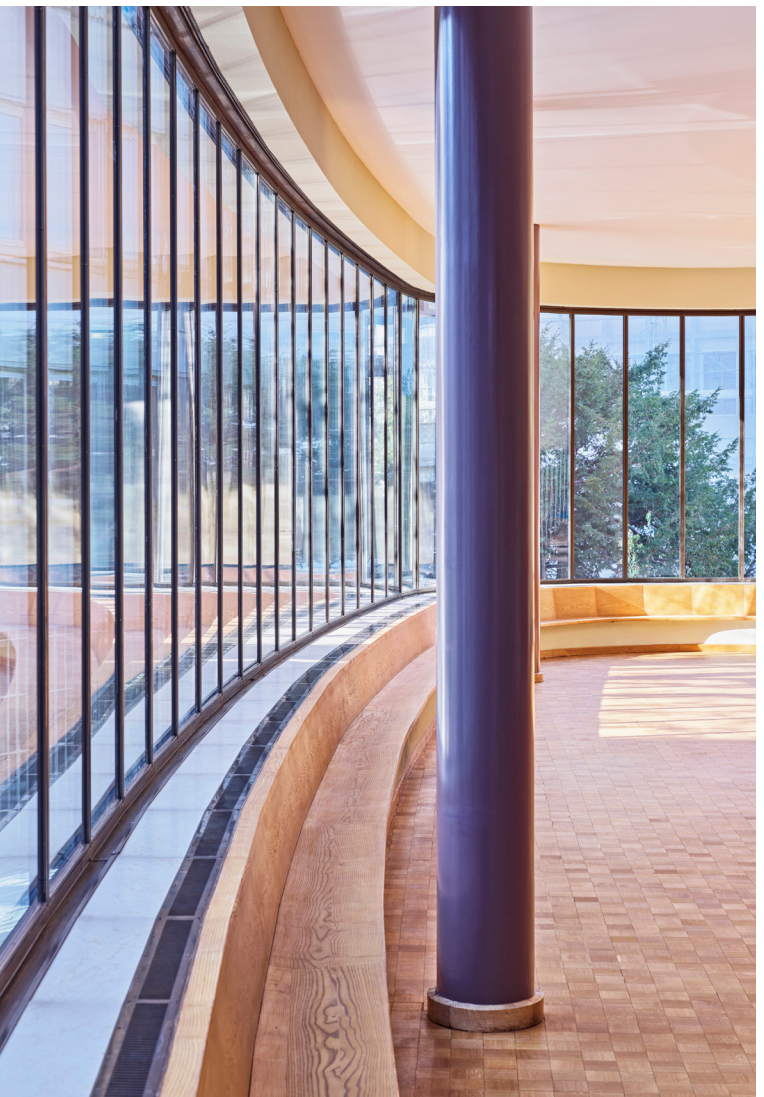
sanierter Verglasung Frontfassade
