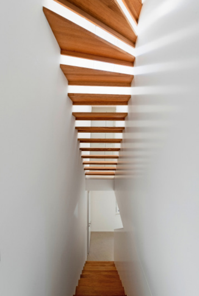
Die Treppe ins Dachgeschoss wurde mit offenen Stufen geplant, wodurch Licht vom Dach bis in den zwei Geschosse tiefer liegenden Eingangsbereich der Wohnung fallen kann.
