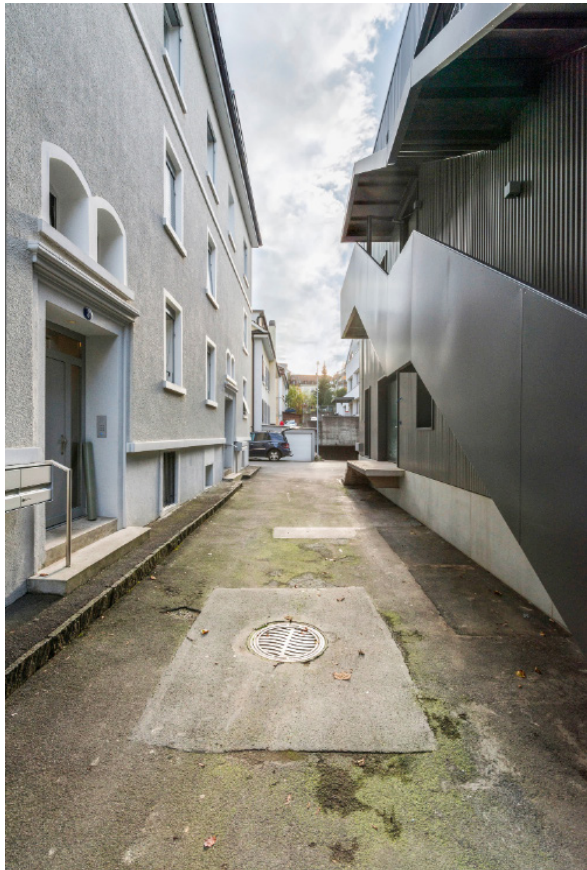
In der Gasse zum Vorderhaus befindet sich die aussenliegende Treppe.
