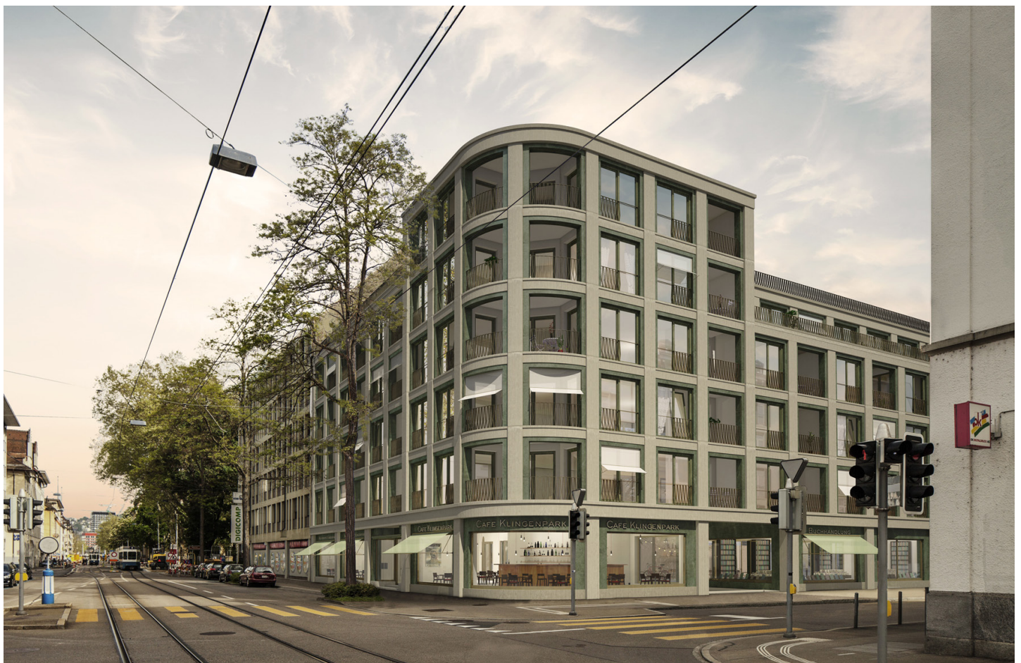
Aussenbild des Apartmenthotels an der Limmatstrasse mit Café und Buchladen im Erdgeschoss
