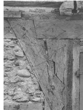
Abb.7 Kopfstrebe mit einseitigem Schwalbenschanzblatt oben und Blatt mit Verzahnung und doppelt geschwungenem Ende unten (1526)
