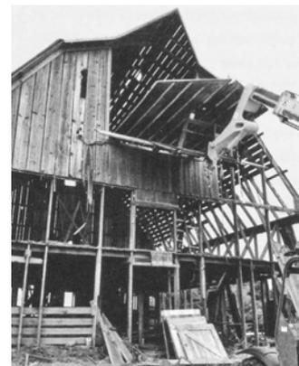
Abb.6 Abriss einer Scheune zur Rückgewinnung des Holzes
