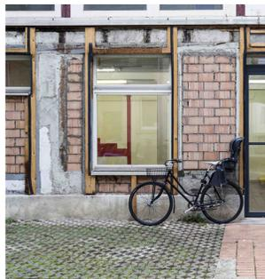
Sichtbares Flickwerk nach Entfernung der Fassadenpaneele
