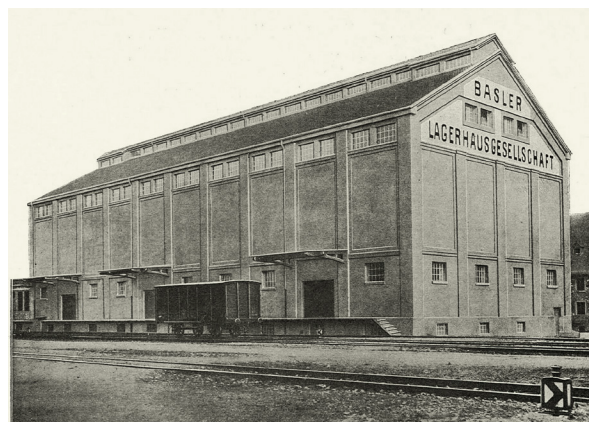
Aufnahme Silogebäude zu Beginn des 20. Jahrhunderts mit der ursprünglich geschlossenen Fassade.
