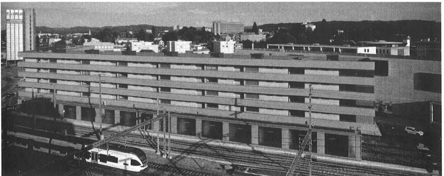
Im nördlichen, längsten Schenkel befindet sich im EG die Zugeinstellhalle der WSB. Kopfseitig im südlichen, kürzeren Schenkel ist die Einfahrt zu Autoeinstellhalle angeordnet.
