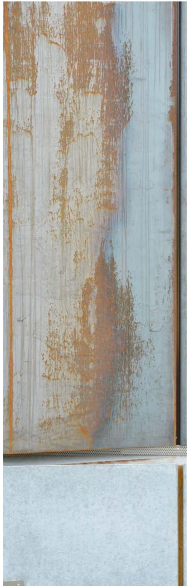
*Detail Fassade: Betonsockelelement mit Regenrinne, darüber die geknickten Rohstahlplatten.*
