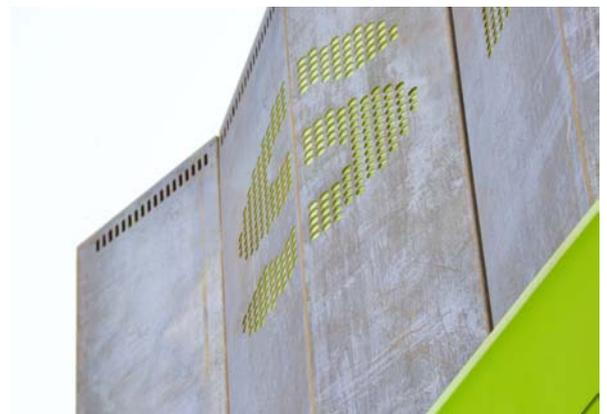
*Die Befestigung der Stahlbleche erfolgt mittels schmalen Leichtmetallkonsolen, damit Meteorwasser nicht liegenbleibt. Die abgeknickten Bleche sind in den Bereichen für die Durchlüftung und Beschriftung perforiert.*
