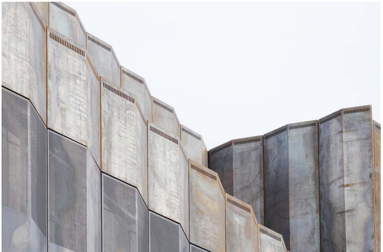
*Staffelung des Baukörpers im Technikbereich: die perforierten Bleche dienen der Luftansaugung der dahinterliegenden Lüftungsgeräte. Die streifenförmige Lochung im Dachrandbereich dient dem Druckausgleich für die Windlast.*
