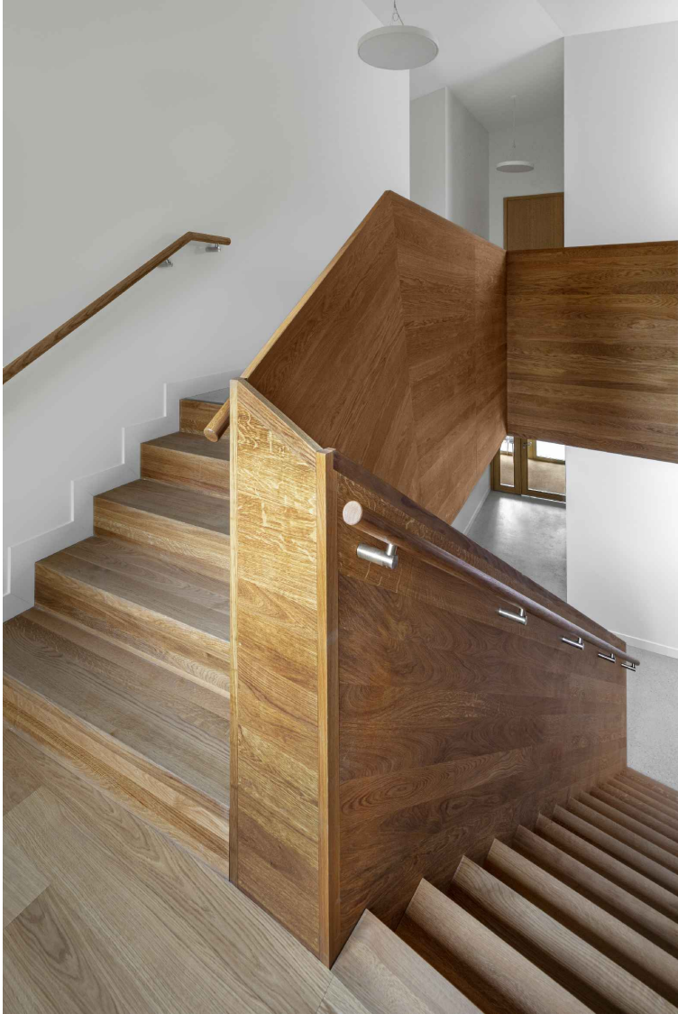
VUE INTÉRIEURE DE L'ESCALIER
