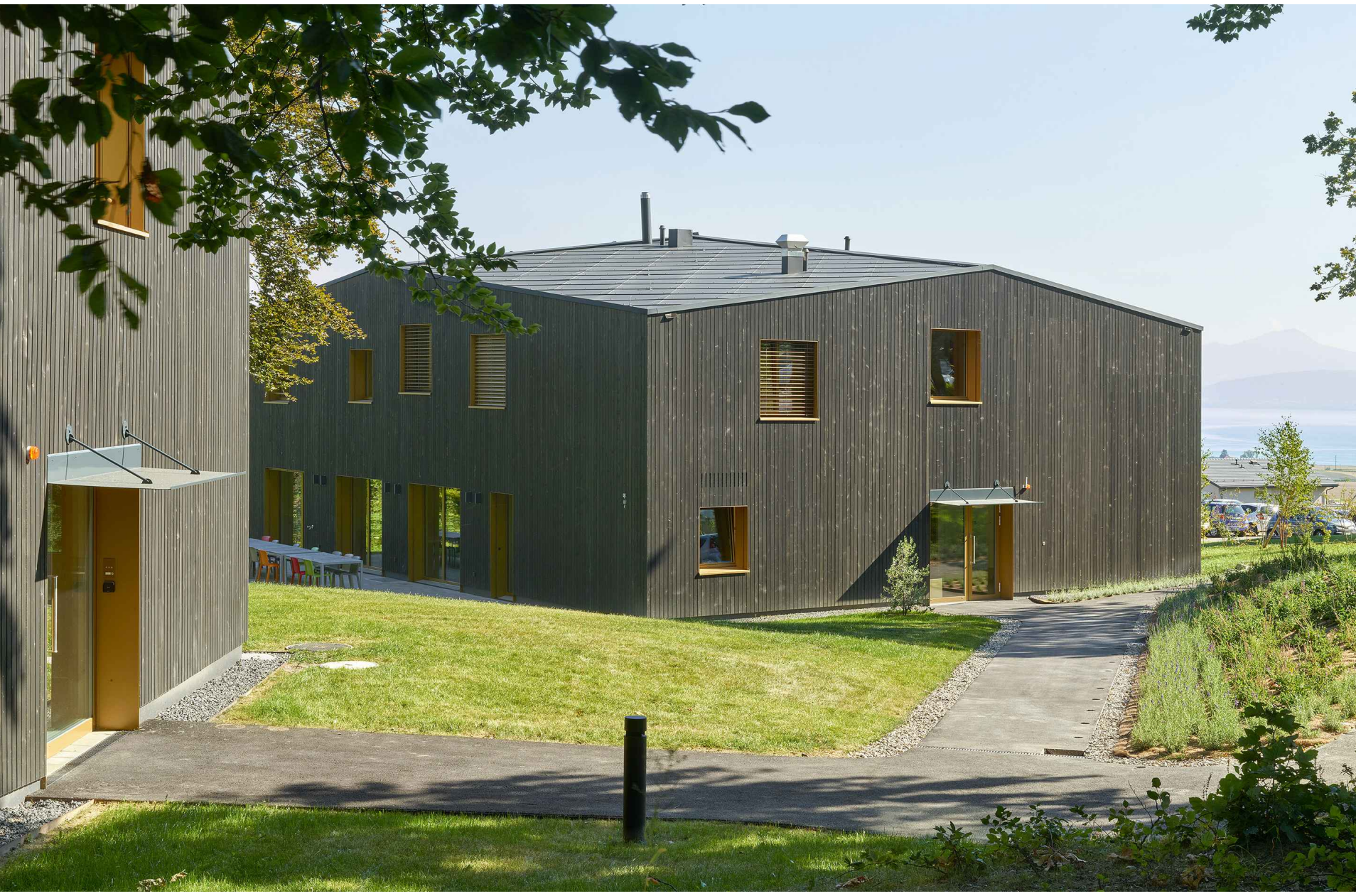
ENTRÉES DES BÂTIMENTS
