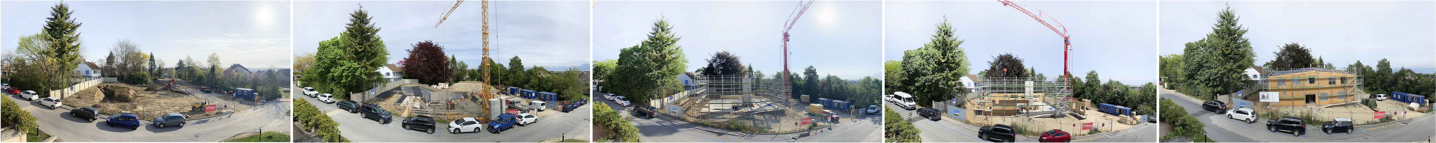
VUE DU BÂTIMENT PENDANT LE PROCESSUS DE CONSTRUCTION
