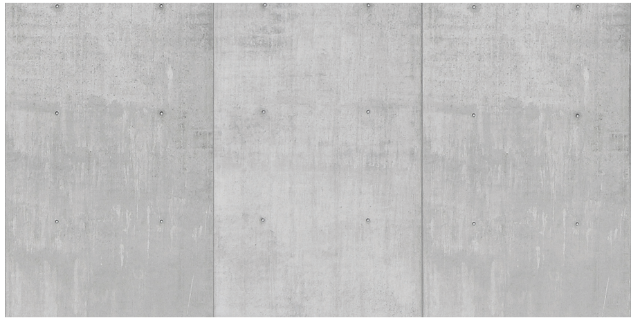
Wand/Decke Sichtbeton Zimmer | Wohnen
