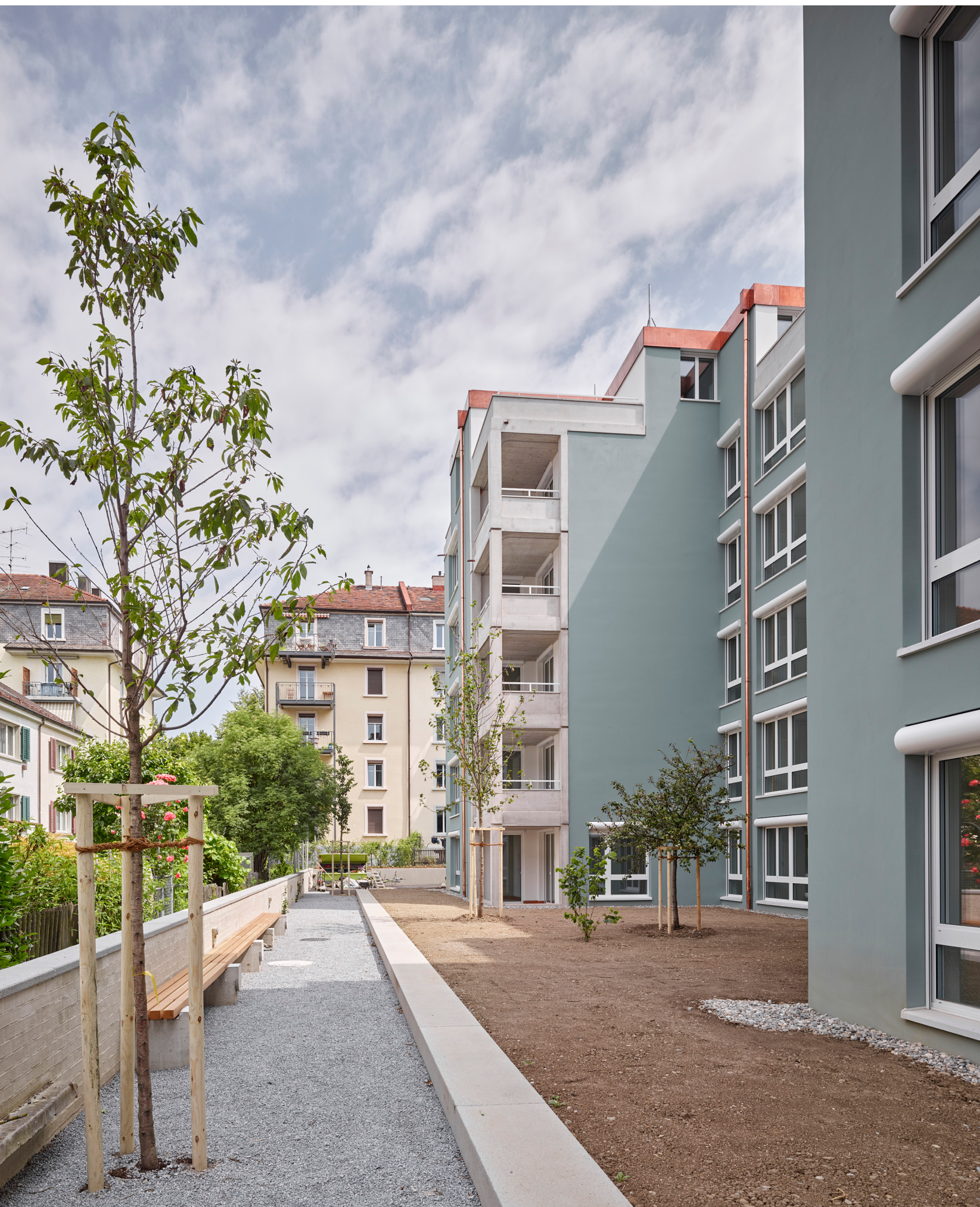
Aus dem Abbruch haben wir Gesimse, Fensterbänke und Fassadenschmuck herausgelöst, um sie dann später in die lange Gartenmauer einzulassen oder als ruinöse Spolien im Garten zu platzieren. Bald werden sie eingewachsen sein und mit den gebauten Elementen zu einer neuen Ganzheit verschmelzen. Es wird eine Geschichte geschrieben, die Vergangenheit und Gegenwart verbindet, zwischen Erinnerung und Erwartung oszilliert.
