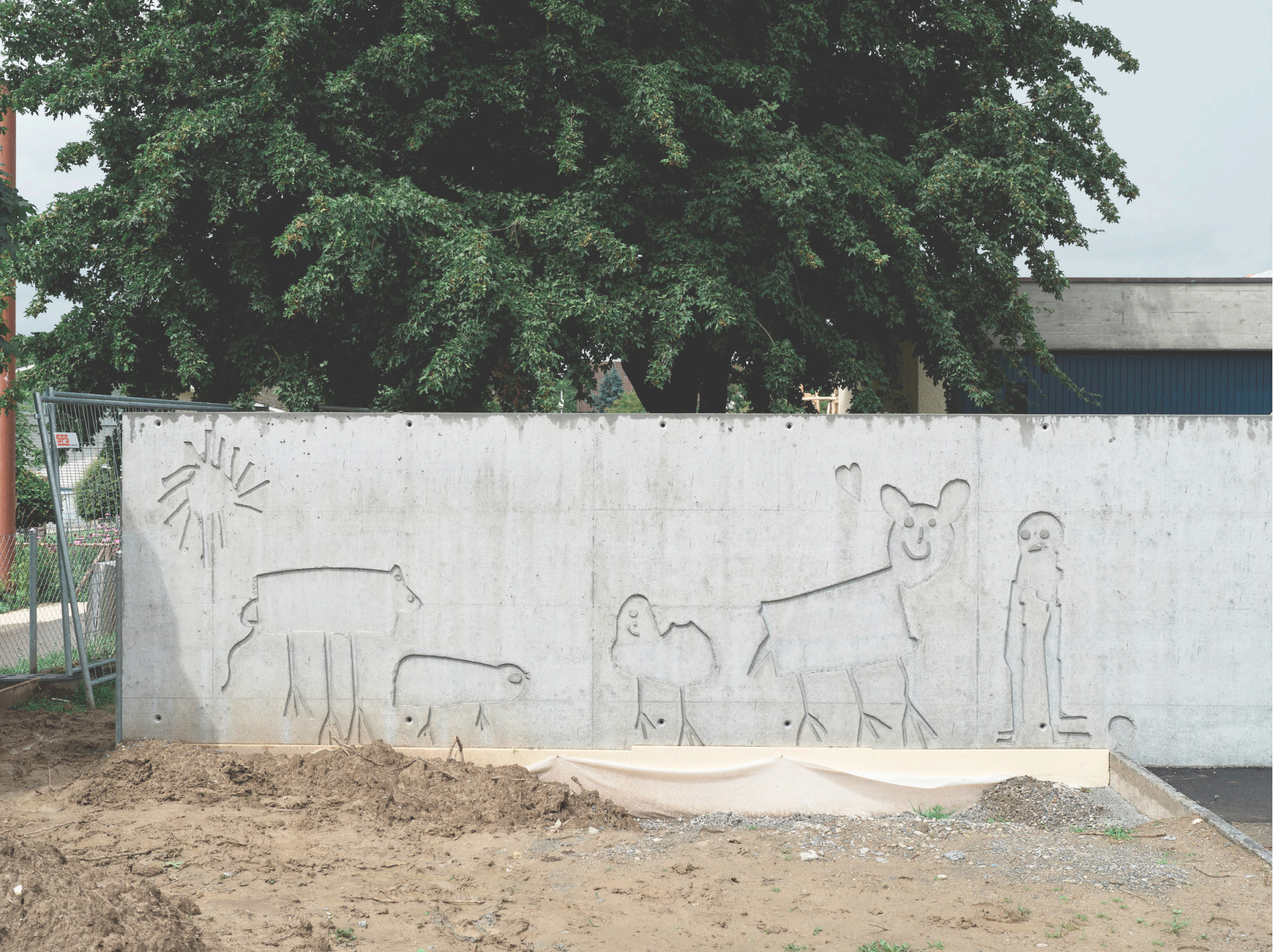
Die Trennwand wird bevölkert von wilden Kreaturen, welche Anhand von Kinderzeichnungen in die Schalung eingelegt wurden.
