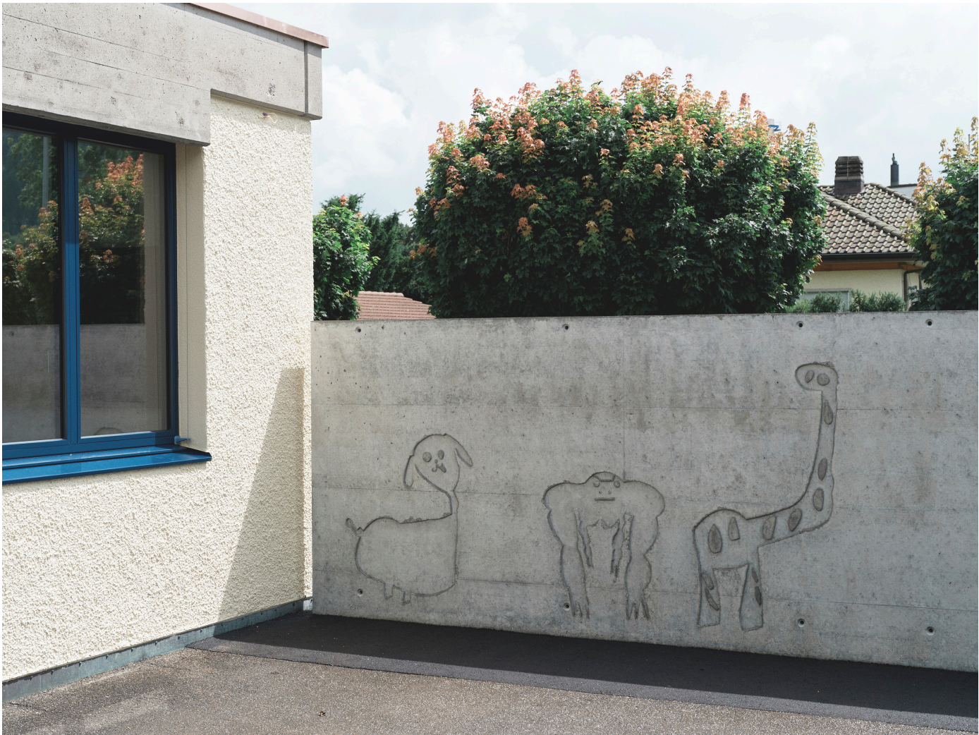
Die Trennwand wird bevölkert von wilden Kreaturen, welche Anhand von Kinderzeichnungen in die Schalung eingelegt wurden.
