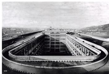
Die Anlieferung der Rohmaterialien kommt von der Mitte und verteilt sich auf zwei Seiten. Von da aus beginnt die Produktion vom untersten Geschoss bis in das Oberste wo das Produkt getestet wird und dann wieder nach unten transportiert und ausgeliefert wird.
