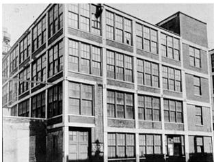
Die Anlieferung der Rohmaterialien ist von der rechten Seite aus. Von da an Wird die Produktion nach Oben und auf die linke Seite geführt. Auf dieser wird dann auch im untersten Geschoss das fertige Produkt wieder ausgeliefert.
