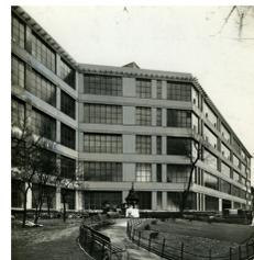
Die Anlieferung von den Rohmaterialien findet von einer Seite statt, diese werden dann ins Lager im Untergeschoss gelagert. Von da aus werden die Rohmaterialien schritt für schritt von unten nach oben verarbeitet. Auf jedem Geschoss befindet sich noch ein Zwischenlager für die Nebenprodukte die zur Produktion dazukommen.
