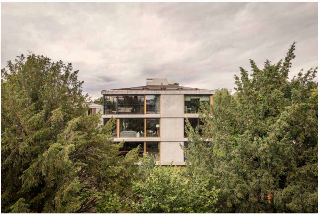
VUE EXTERIEURE VILLA C
