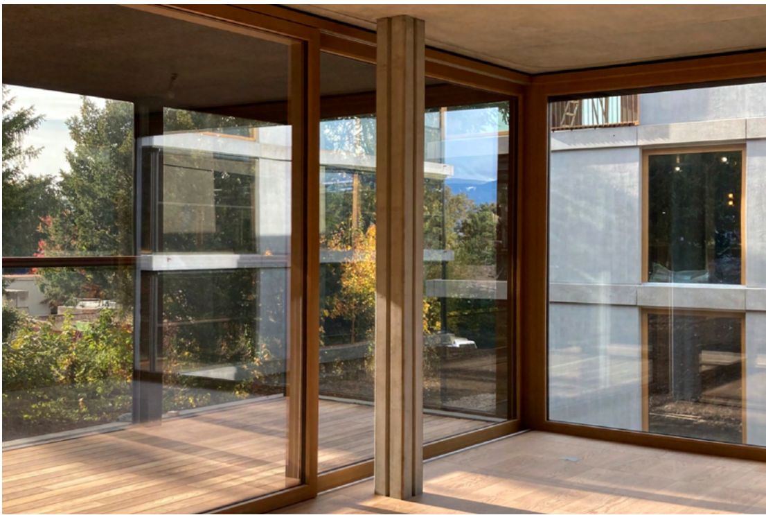
SALON LOGGIA APPARTEMENT - POTEAU BETON EN FORME DE CROIX
