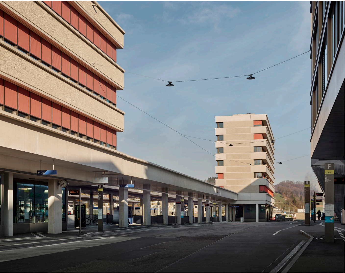
Parallel zu den Gleisen wird das Bahnhofumfeld neu geordnet.
