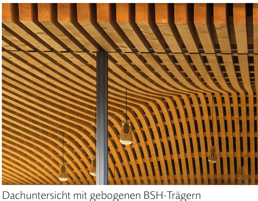
Dachuntersicht mit gebogenen BSH-Trägern
