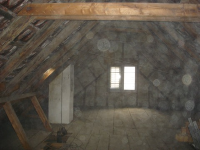
2. Dachgeschoss, Blick Richtung Norden
