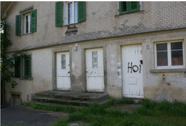
Detail Nordfassade. Die Türe rechts wurde 1950 für die Waschküche ausgebrochen.
