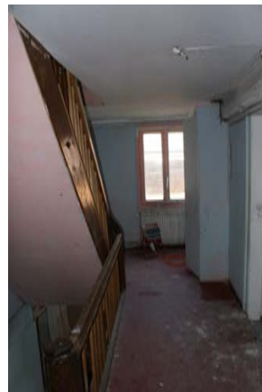
Mitte links: Eckzimmer 15, Blick nach Nordost
