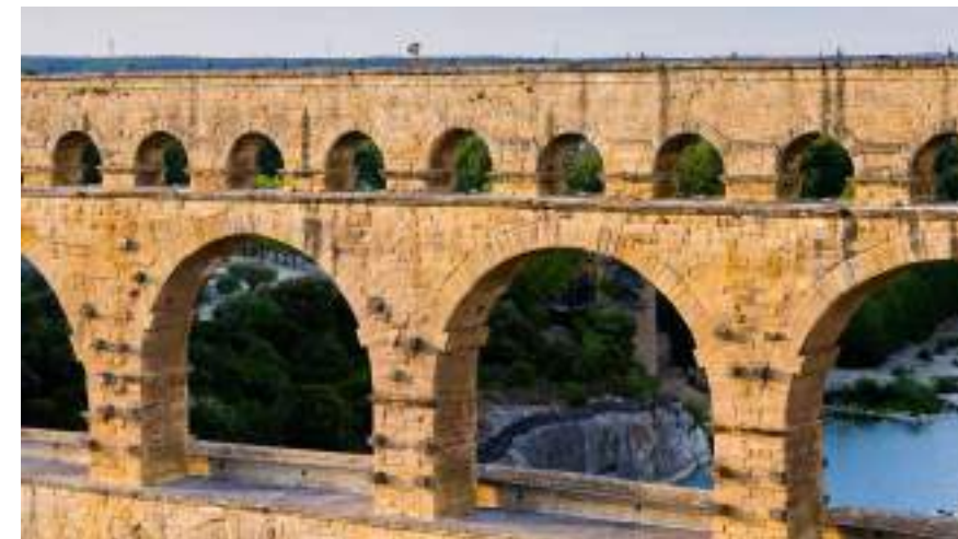
Pont de Gard . pierres irrégulières pour ancrer l'échafaudage . répétition
