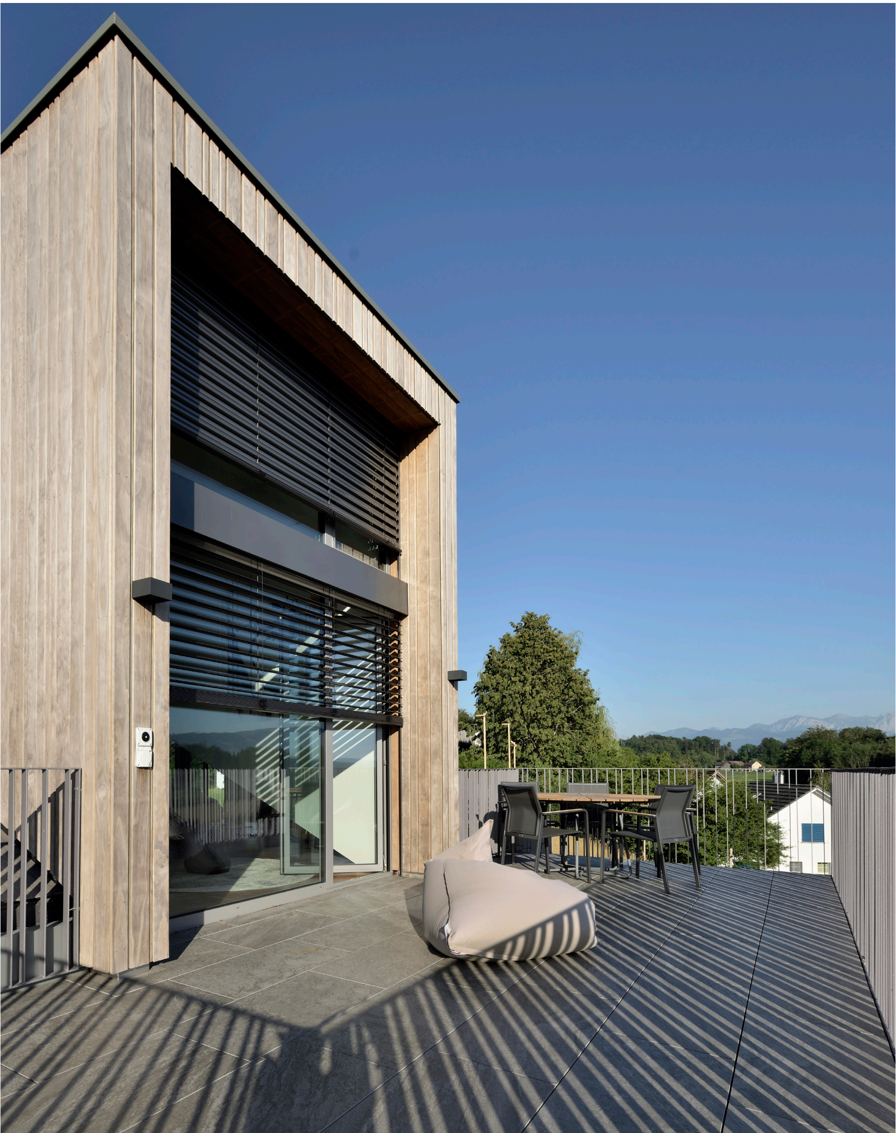
Die Lukarnen sind mit einer biopolymer-impregnierten, vertikalen Wechselfalzschalung aus Nadelholz verkleidet.
