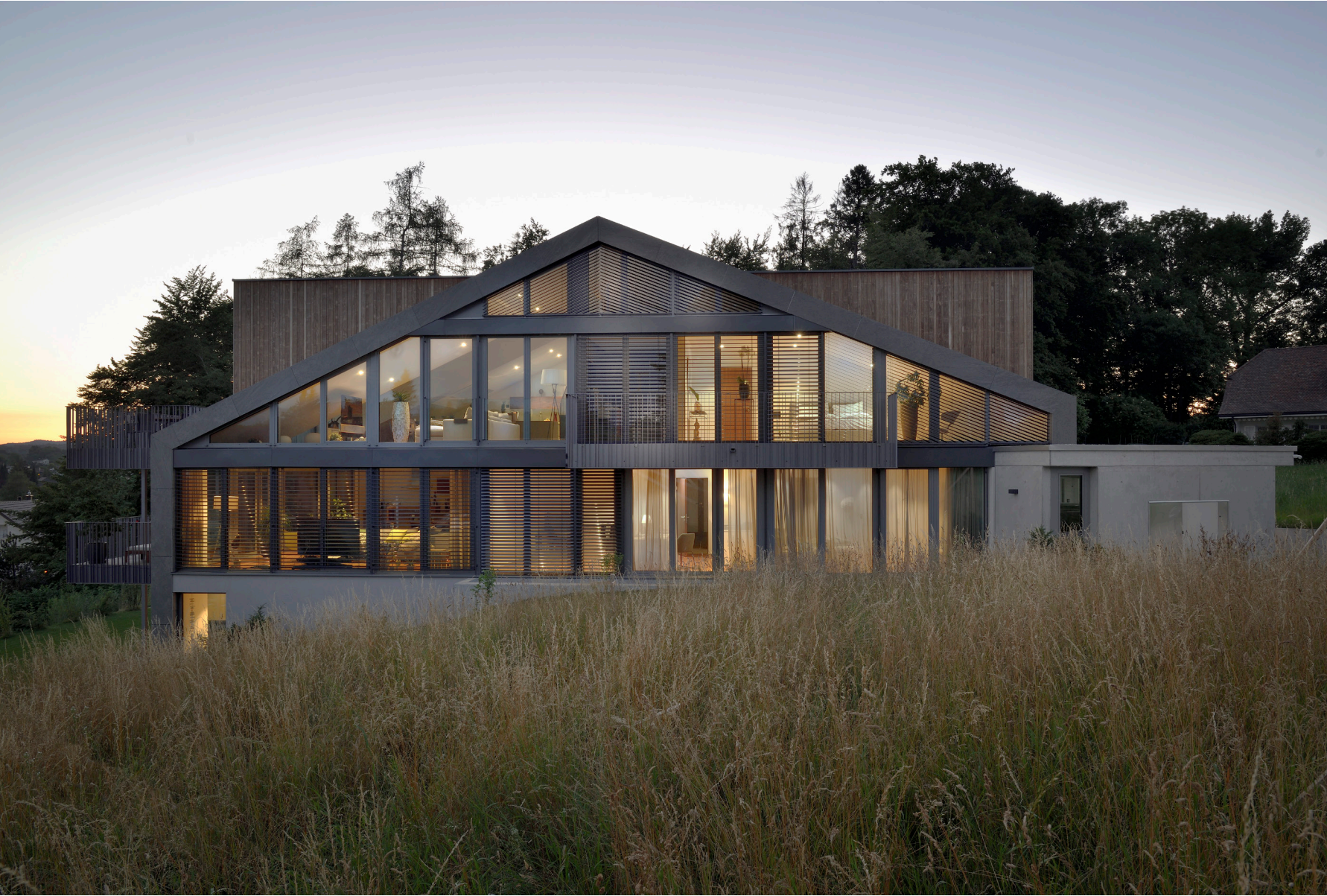
Mit Feinsteinzeugplatten verkleidete Schrägdächer und markante Lukarnen aus Holz schaffen Bezüge zur ländlichen Umgebung.
