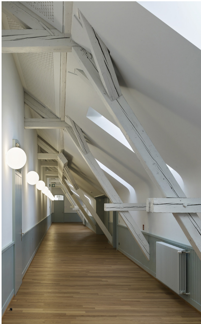
Korridor über Dachflächenfenster natürlich belichtet
