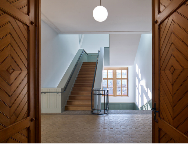
Zwei neue Treppenläufe zur Erschliessung Dachgeschoss
