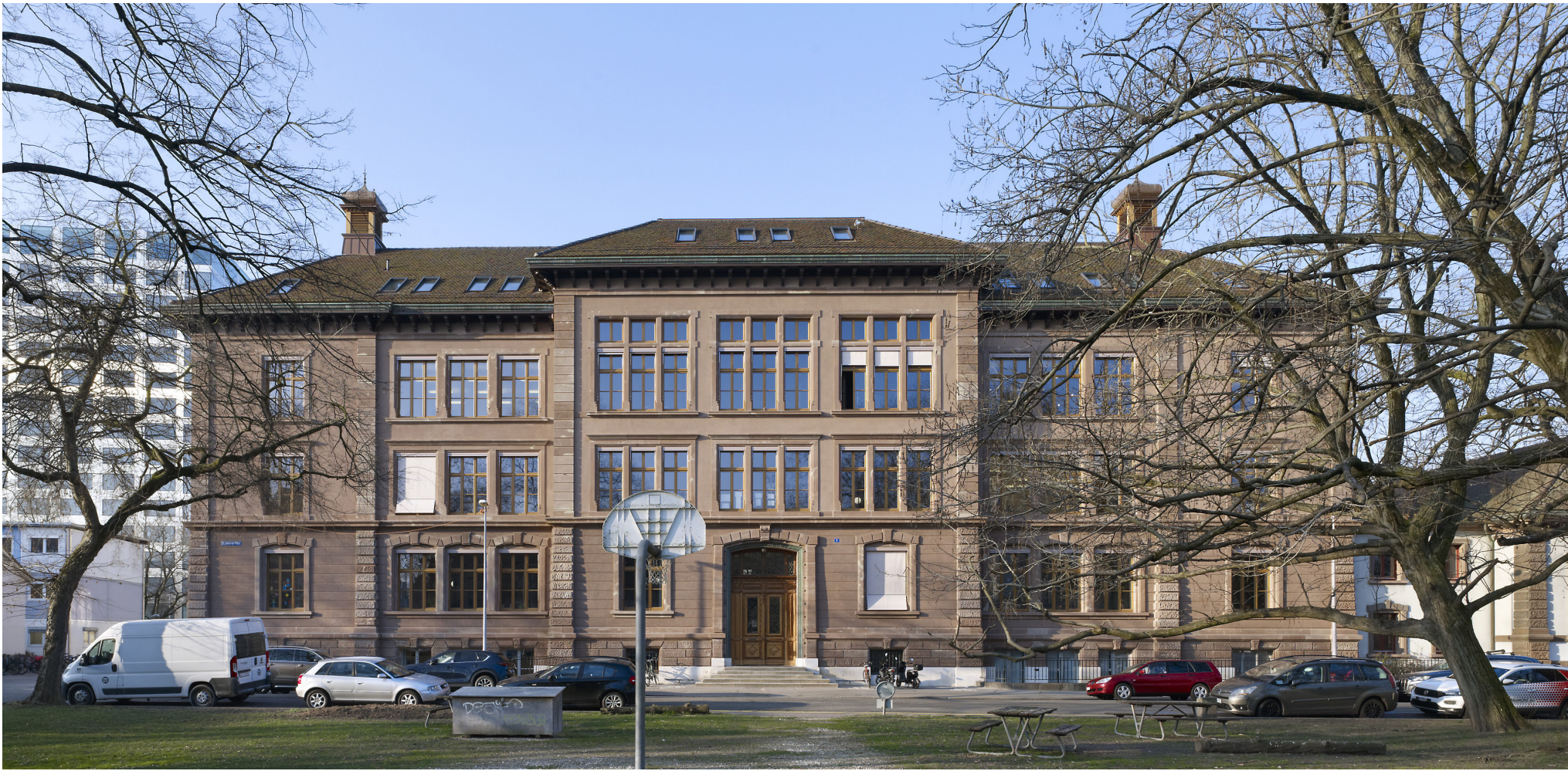
Hoffassade nach der Sanierung
