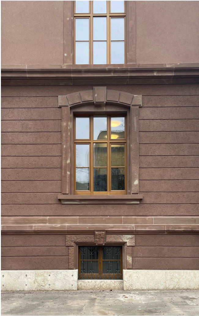
Neuer Natursteinelemente, Sockelputz rustifiziert und farbig pigmentiert
