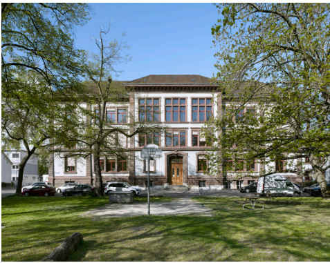
Hoffassade vor der Sanierung
