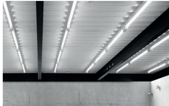
Eclairage artificiel Plafonnier à réglettes avec tubes fluo. 1200 mm
