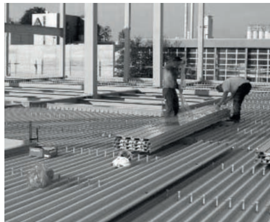
Pose des tôles sur le chantier
