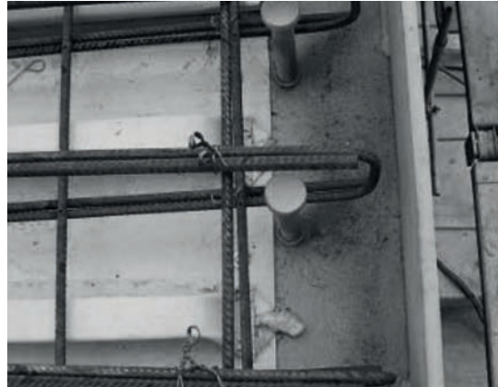
Équerre en bord de dalles
