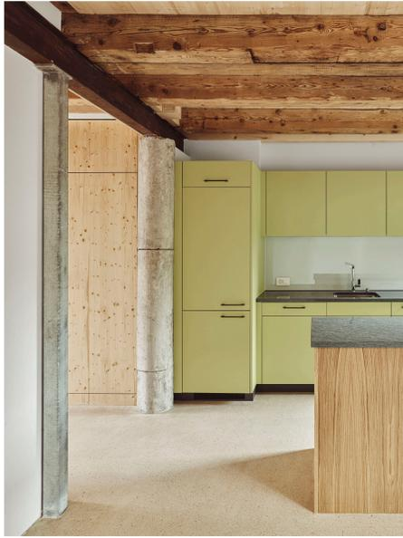
Freigelegte Tektonik in der Küche: Betonstütze, Stahlträger und Balken
