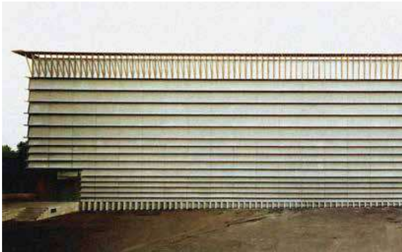
Abb. 51. Jedes Element der Fassade des Ricola-Lagerhauses von HdM ist eine Art Lagerrahmen, in dem Teile der Verkleidung gelagert werden und so die Funktion des Gebäudes nach aussen zeigt.
