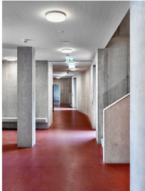
Blick in den Eingangsbereich des Wohntrakts mit roh geschaltem Beton und rot abgesetztem Bodenbelag.
