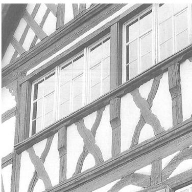
Abb. 8, Fensterwagen mit konsolengestütztem Brüstungsriegel 1690, Altnau
