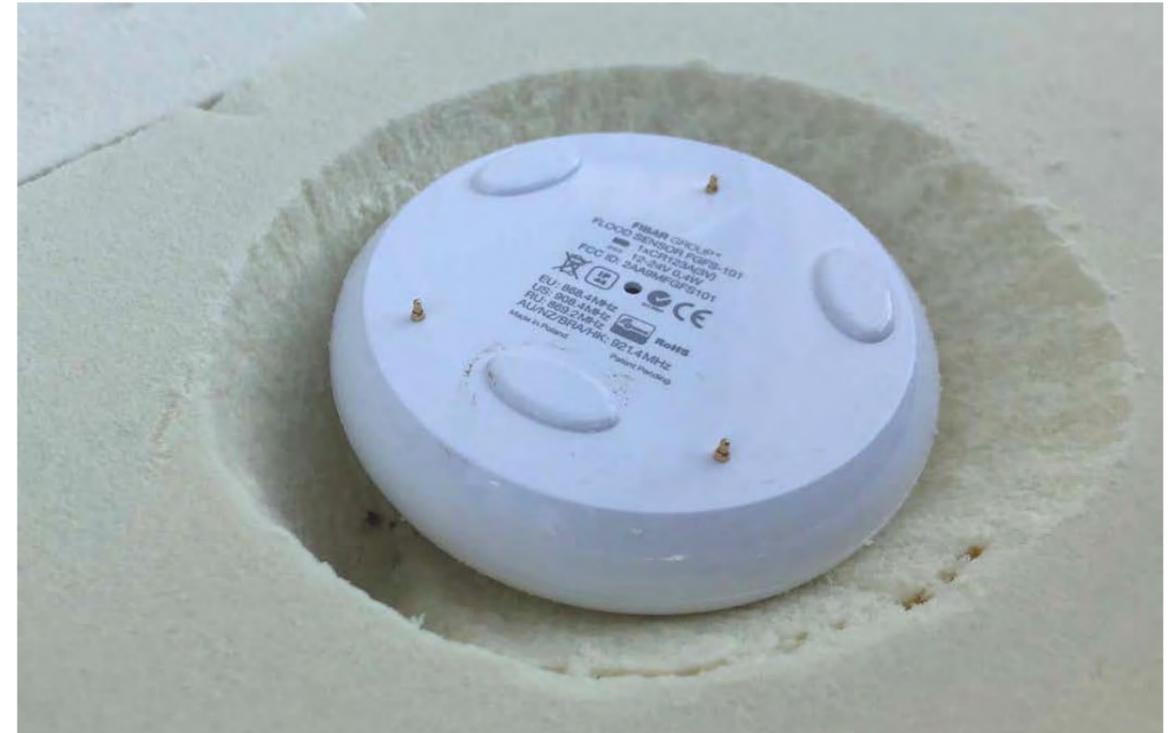
IOT WLAN Sensor in Isolationsausschnitt
