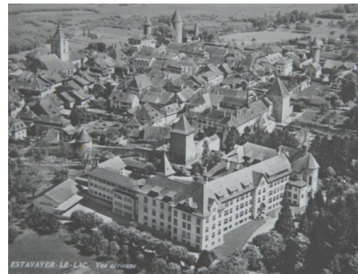
Pensionat du Sacré-Coeur après 1954
