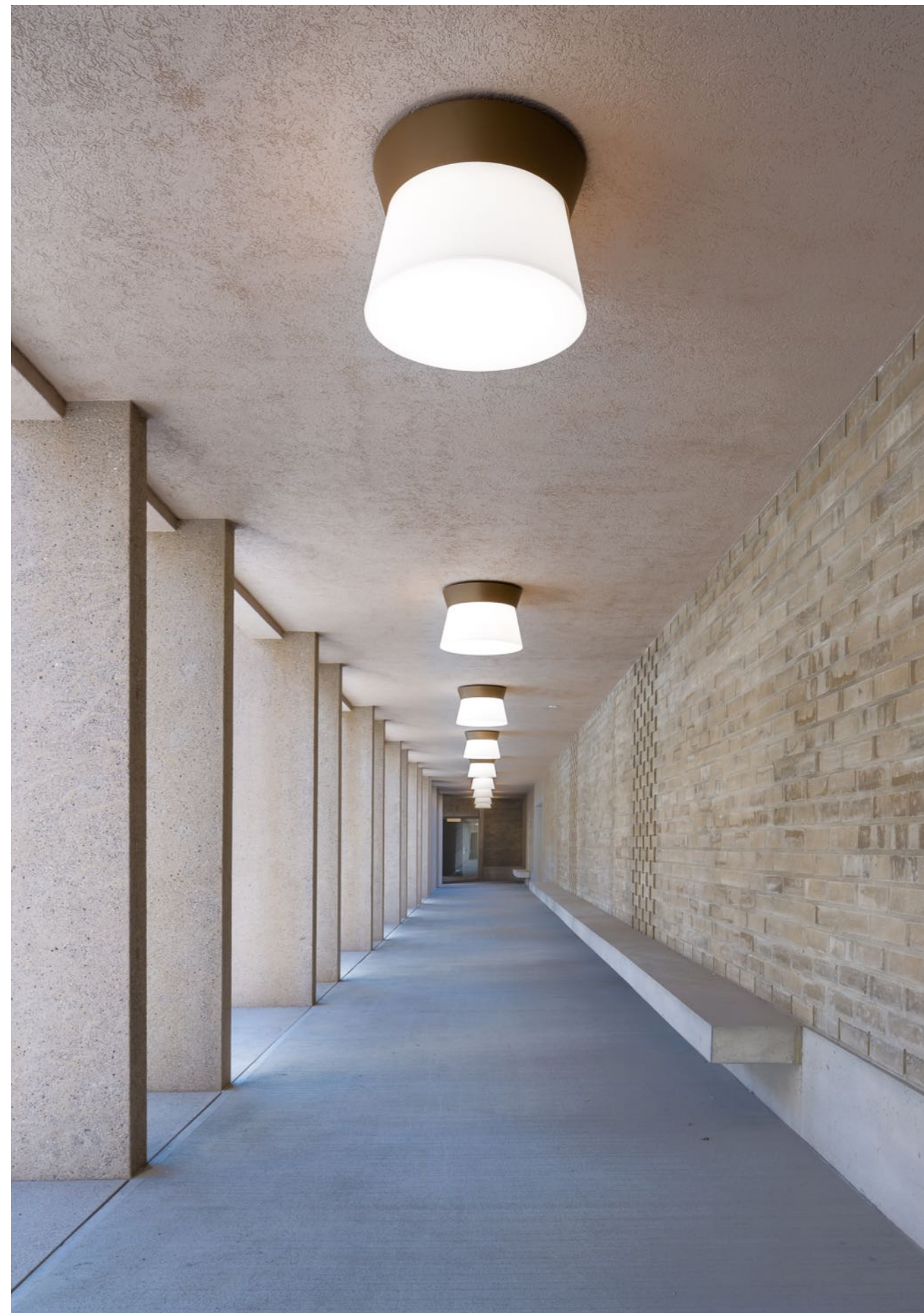
L'arcade, préau couvert de la cour d'école et espace de distribution
