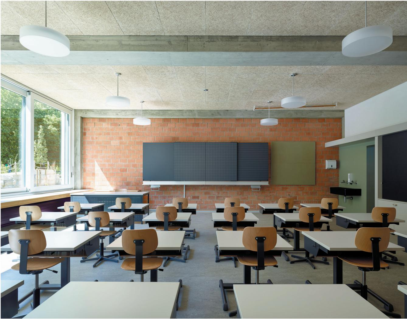
Das Schachenschulhaus wurde 1967/68 vom lokal bekannten Architekten Emil Aeschbach als Primarschulhaus realisiert. Das Gebäude ist geprägt durch eine klare architektonisch-strukturelle Gliederung mittels Sichtbetonunterzügen und ausfachenden Sichtbacksteinwänden. Die Fassade wird seit einer ersten Fassadensanierung Anfangs der 2000er-Jahre gebildet durch grosszügige Schiebefensterlelemente und Brüstungsverkleidungen in Eternit. Auf Grund steigender Schülerinnenzahlen bestand Erweiterungsbedarf.
