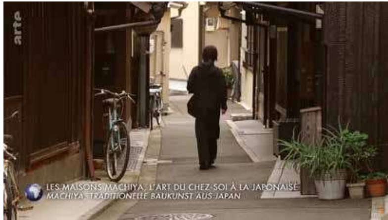
Abb. 36. Eine typische Strassenszene in den alten Quartieren Kyotos. Die Holzhäuser formen enge Gassen. Schwellen und Materialunterschiede begleiten die Strasse und schaffen eine Zwischenzone
