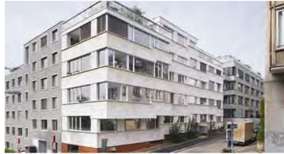
Mehrfamilienhaus an der Ecke Damm-/Habsburgerstrasse, Haustein La Roche Scheder Architekten, 2011
