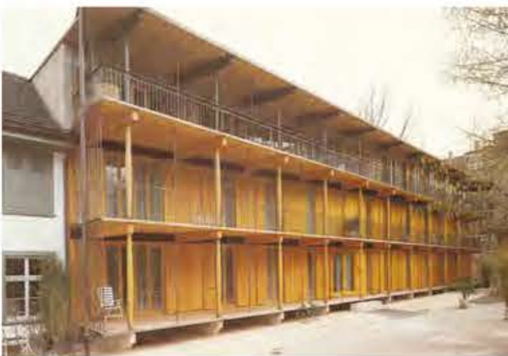
Mehrfamilienhaus Basel, Herzog & de Meuron 1988
